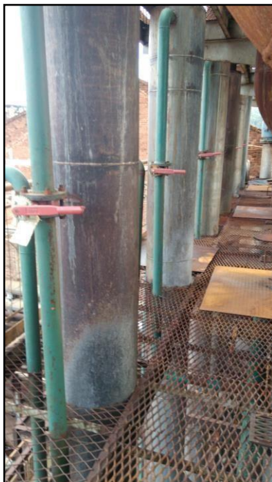
Figura 24 – Local de substituição das válvulas.
