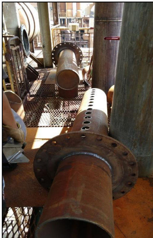
Figura 25 – Substituição de tubulações novas.
