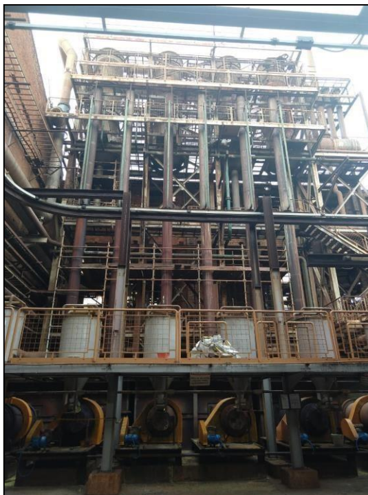
Figura 22 – Manutenção nas colunas de gás para sanar vazamentos.
