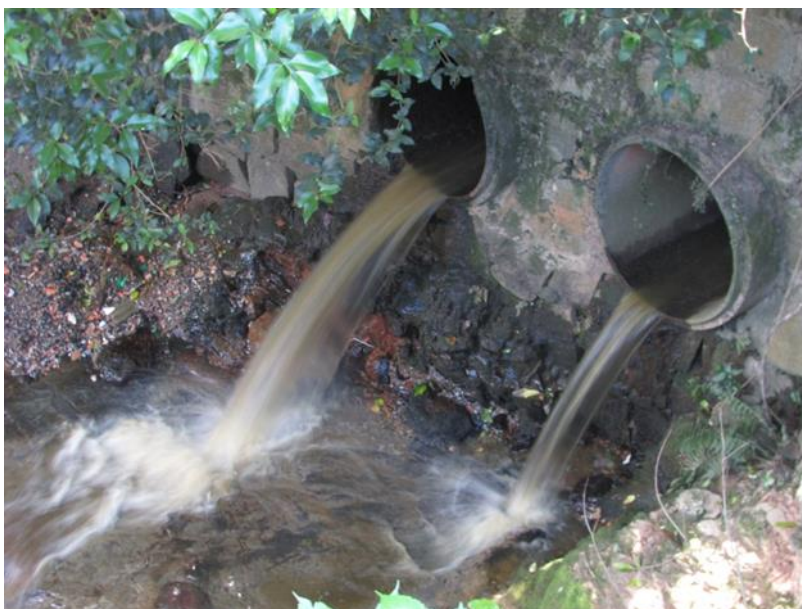
Figura 2 - Manilhas de lançamento do efluente proveniente da ETA.
