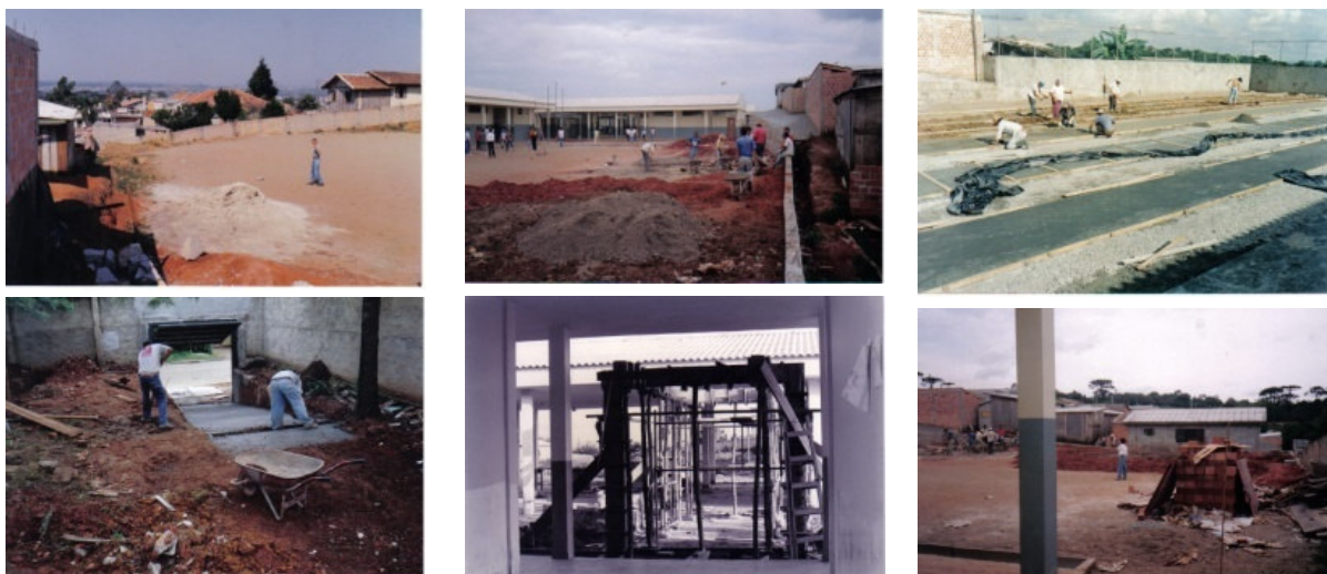
Figura 5: Fotos da construção do Colégio
