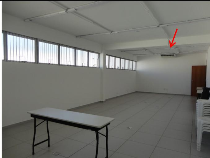
Ar condicionado não previsto em projeto original e estava instalado em sala menor (primeiro fechamento da garagem). Após ampliação (fechamento total da garagem) para nova sala de reuniões, verifica-se que o equipamento está subdimensionado para o ambiente.
