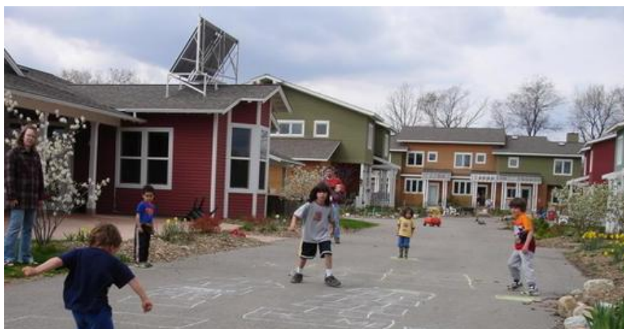
Figura 8 - Sistema solar de aquecimento de água sobre a casa comum
