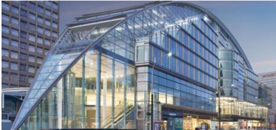
Figura 2 – Edifício 80-100 Victoria Street
