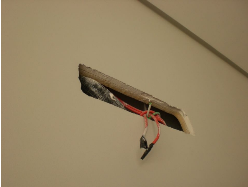
Figura 20 – Abertura para saída de fiação: a localização de conduites foi prevista em projeto
