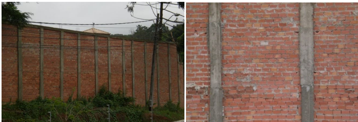
Figura 4 – Exemplo de parede construída na forma tradicional de alvenaria
