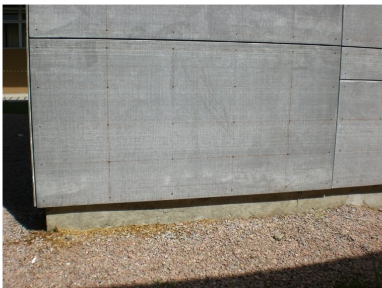
Figura 13 – Placa cimentícia colocada na parte externa de projeto piloto em Wood Light Frame
