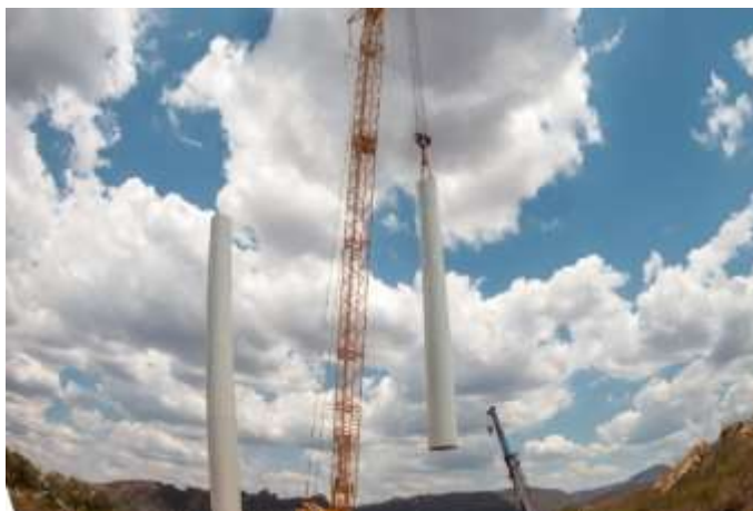
Figura 11 - Montagem do tramo final
