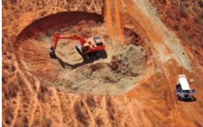
Figura 7 - Escavação da base do aerogerador
