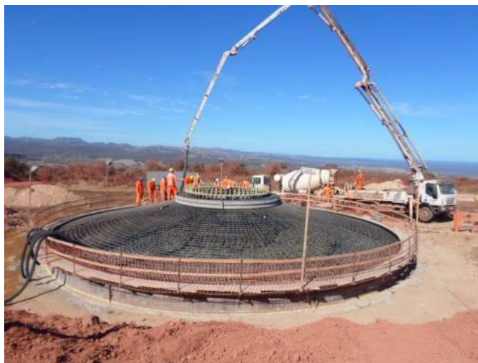
Figura 9 - Concretagem da base
