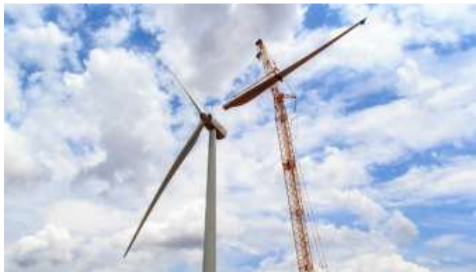
Figura 13 - Montagem do rotor e pás
