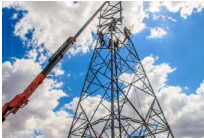
Figura 10 - Execução de uma torre da linha de transmissão
