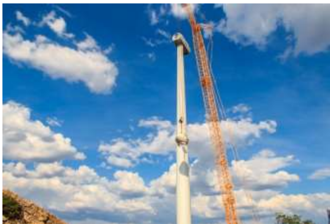
Figura 12 - Montagem da nacelle
