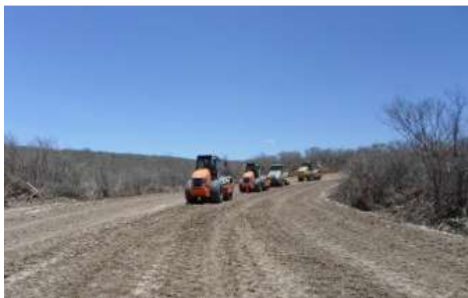
Figura 6 - Terraplenagem dos acessos internos do parque eólico
