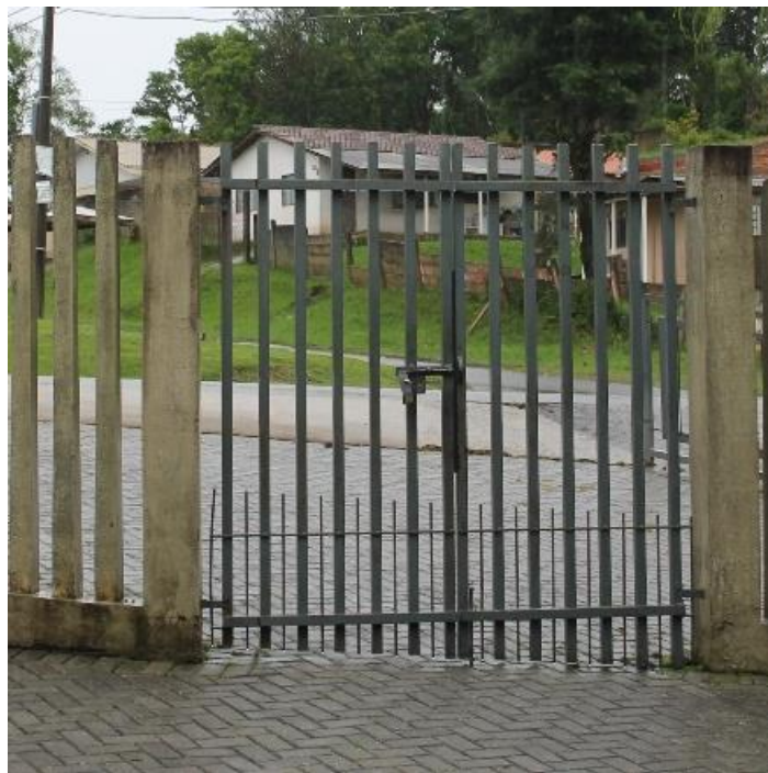
Figura 5 - Portão de acesso a pedestres Fonte: Autoria própria (2015)
