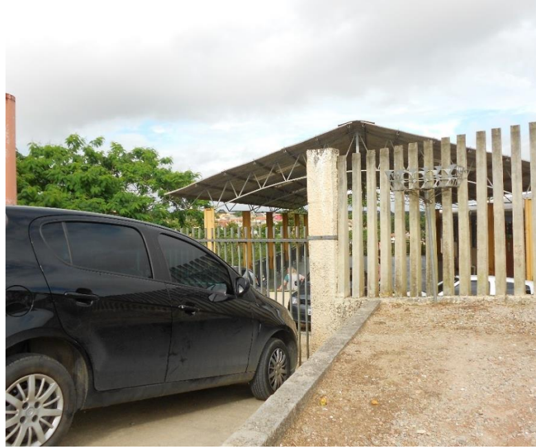
Figura 6 - Portão de acesso a carros Fonte: Autoria própria (2015)
