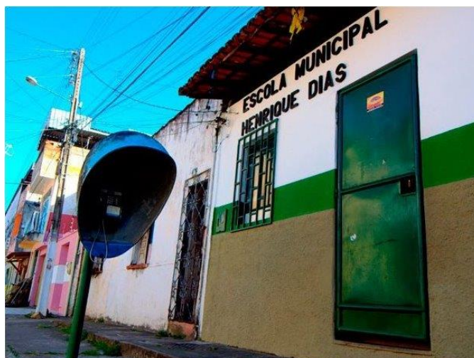
Figura 2 - Incêndio em escola municipal no Estado da Bahia Fonte: G1 (2015b)
