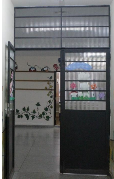
Figura 9 - Porta de acesso do corredor para o salão interno Fonte: Autoria própria (2015)
