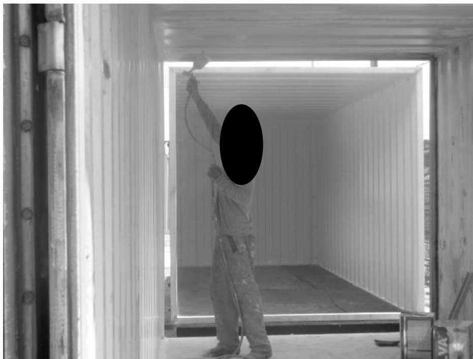
Figura 8 - Pintura através de um pulverizador Fonte: a Autora, 2018
