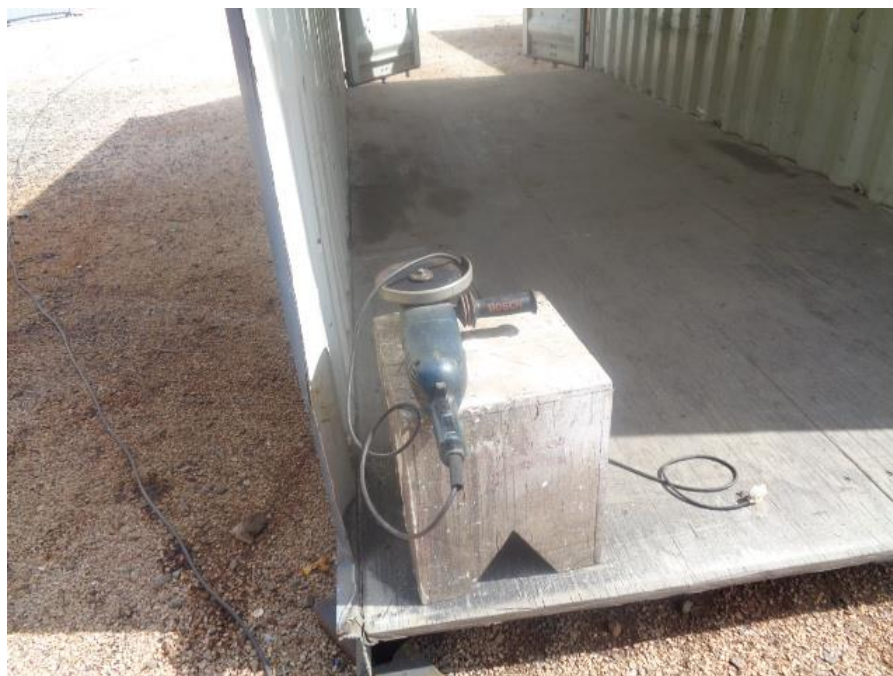
Figura 6 - Esmerilhadeira utilizada nos cortes Fonte: a Autora, 2018
