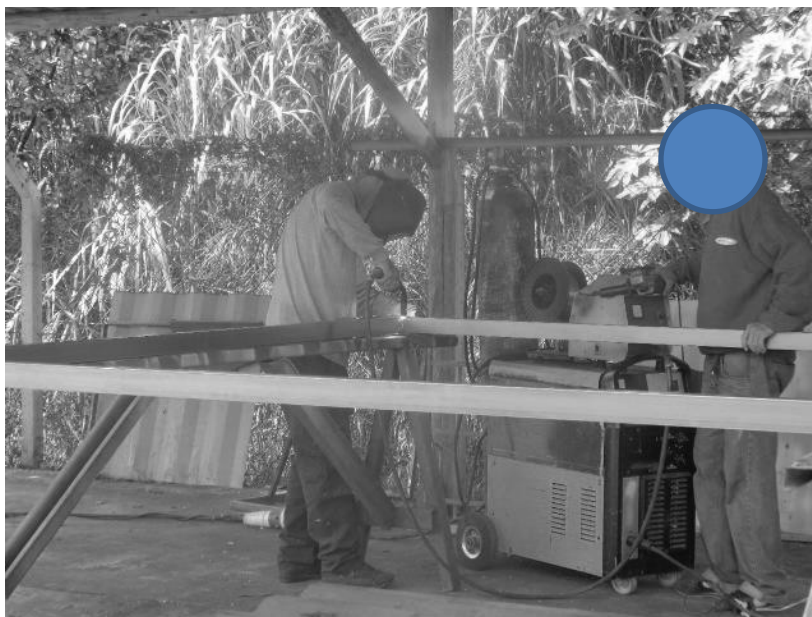
Figura 7 - Serviço de Soldagem Fonte: a Autora, 2018
