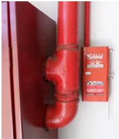
**Figura 25 – Detalhe das botoeiras de acionamento do alarme contra incêndio**
