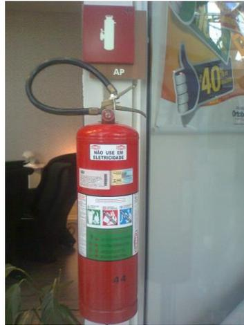
**Figura 3 – Exemplo de extintor de Água Pressurizada em Centro Comercial**
