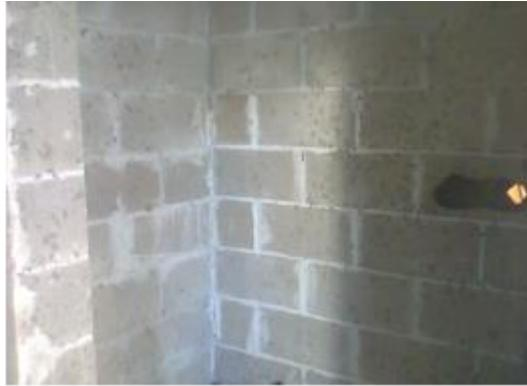
**Figura 19 – Exemplo de parede corta fogo em Centro Comercial – Blocos de Concreto**
