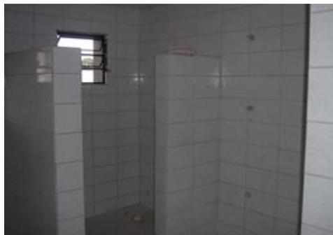
**Figura 23 – Revestimento cerâmico de paredes – fase final da obra**
