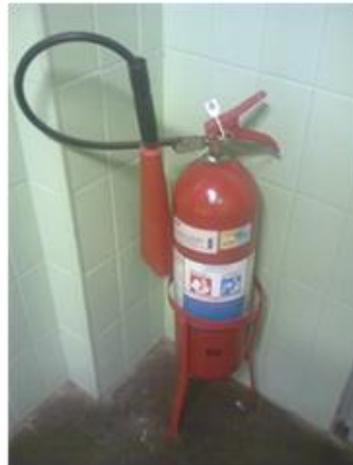
**Figura 4 – Exemplo de extintor de Gás Carbônico em Centro Comercial**
