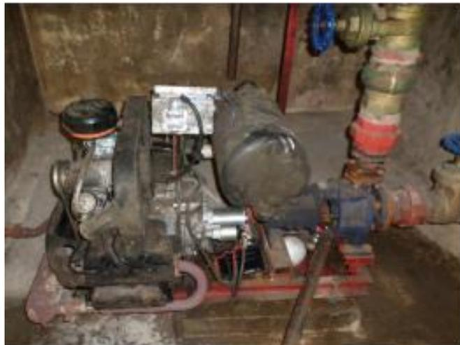
**Figura 30 – Detalhe da bomba a combustão**
