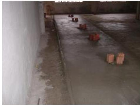
**Figura 21 – Piso em concreto desempenado durante a execução da obra**
