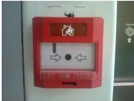
**Figura 10 – Detalhe de Acionador Manual em Centro Comercial**
