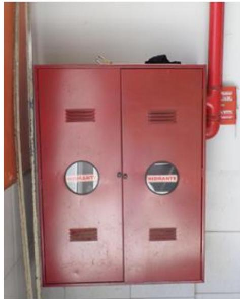
**Figura 28 – Detalhe do abrigo para Hidrante Duplo com botoeira de acionamento**
