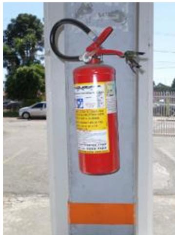
**Figura 26 – Detalhe da unidade extintora sem sinalização adequada
