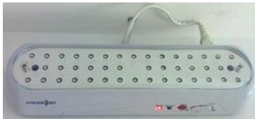
**Figura 13 – Detalhe bloco autônomo de iluminação em Torre Comercial
