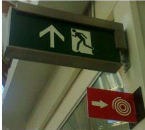
**Figura 14 – Sinalização de Rota de Fuga e Hidrantes em Centro Comercial**
