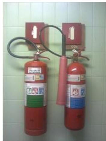
**Figura 5 – Exemplo de bateria de extintores para risco específico em Centro Comercial**
