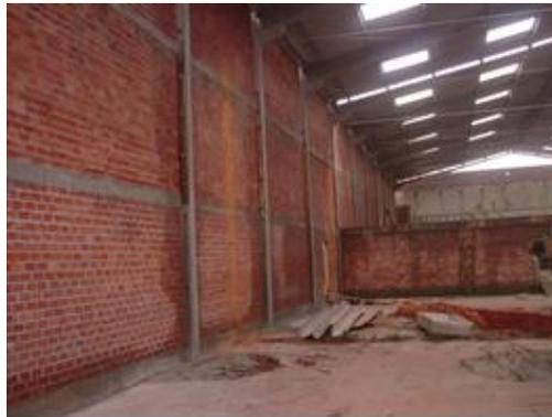
**Figura 20 – Parede feita em tijolos de cerâmica no empreendimento analisado**
