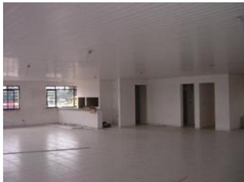
**Figura 22 – Piso cerâmico e forro de PVC – fase final da obra**
