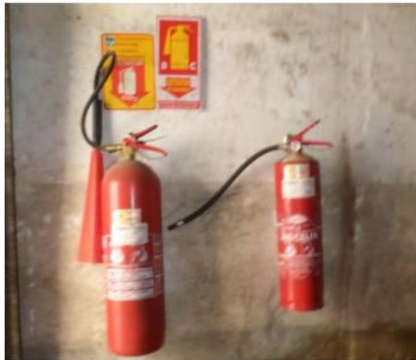
**Figura 27 – Detalhe dos extintores dedicados à Casa de Bombas – falta de sinalização adequada**
