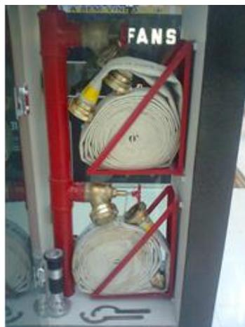
**Figura 7 – Exemplo de abrigo para hidrante duplo em Centro Comercial**
