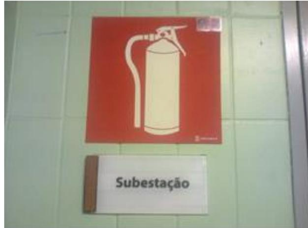
**Figura 6 – Exemplo de identificação de extintor para risco específico**
