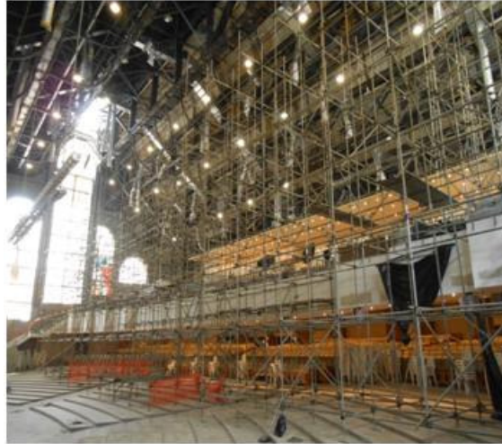
Figura 27: Instalação de andaimes tipo tubular na área interna.
