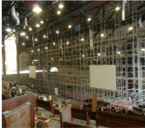
Figura 18: Andaime tipo fachada sem apoio.
