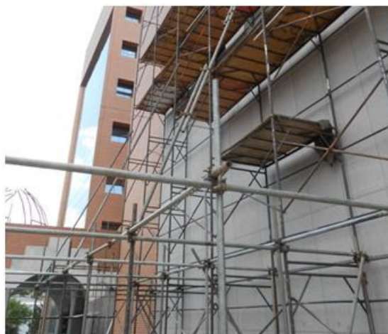
Figura 28: Instalação de andaimes tipo tubular na área externa.
