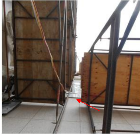
Figura 21: Andaime tipo fachada sem apoio.
