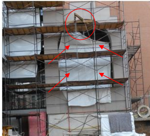
Figura 22: Içamento ligado a andaime tipo fachada.
