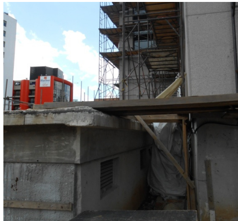
Figura 20: Base do andaime sobre estrutura em madeira.
