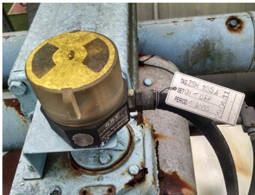
Figura 14 - Válvula Controladora de Líquido Fonte: O Autor.
