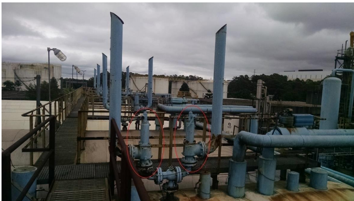
Figura 13 - Válvula de Segurança Fonte: O Autor.
