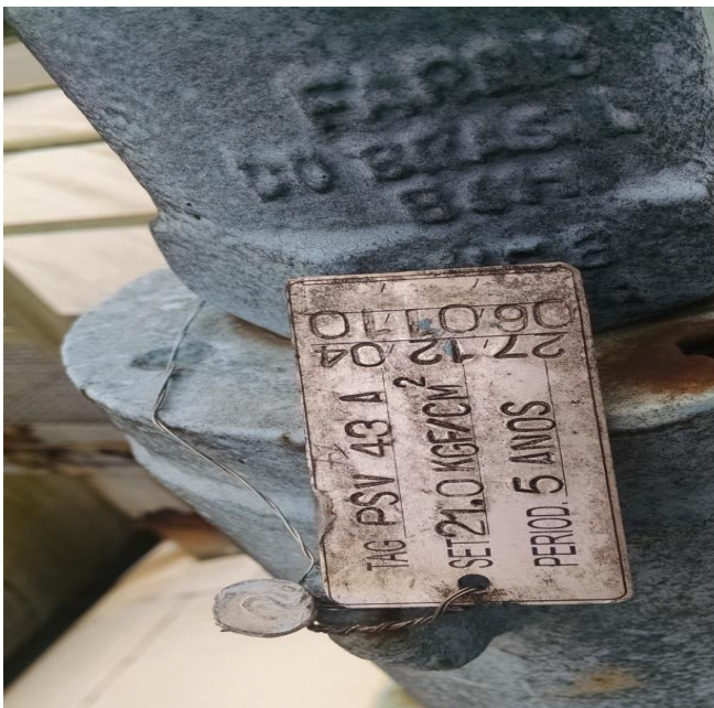
Figura 15 - Placa de Calibração da Válvula de Segurança Fonte: O Autor.
