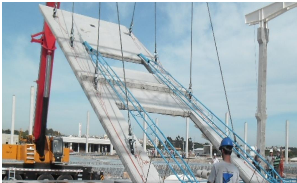
Figura 30 - Içamento, Lifts, Peças metálicas , escoramento, cordas.
