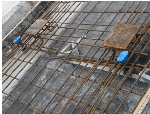
Figura 24 - Lifts armados para concretagem.
