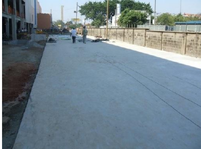
Figura 5 - Pista de execução
