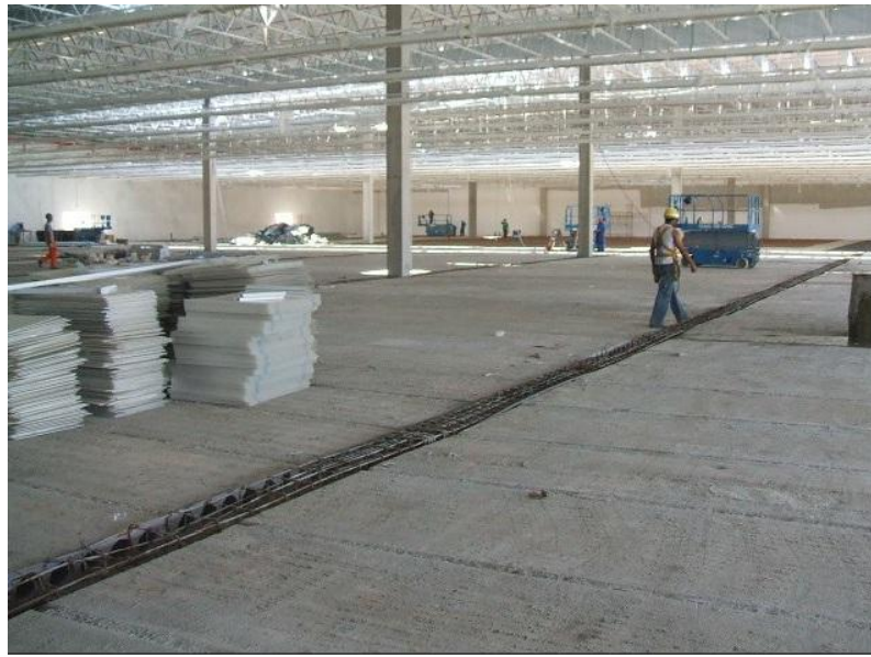
Figura 14 - Típica construção no sistema Tilt-up
