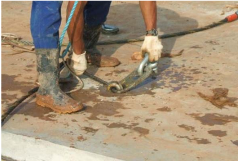
Figura 8 - Fixação de cabos de aço nas placas.
