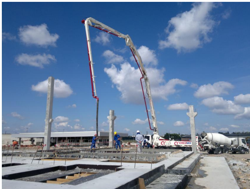
Figura 6 - Concretagem Paredes Tilt-up
