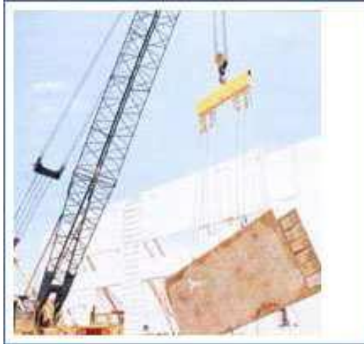
Figura 2 – Içamento de parede Tilt-up
