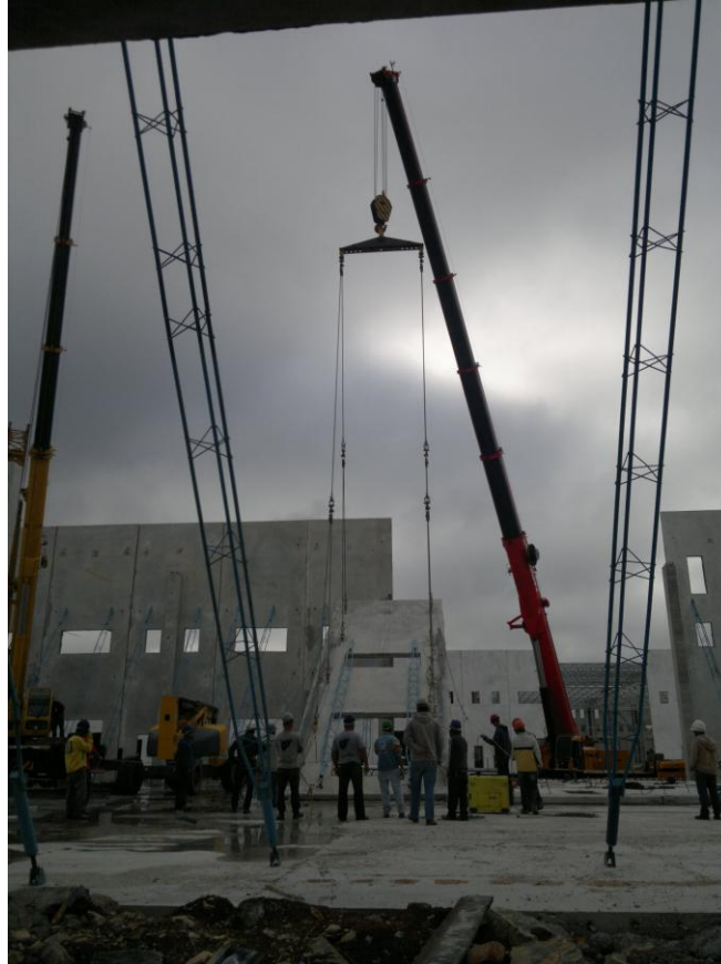
Figura 13 - Içamento parede Tilt-up
