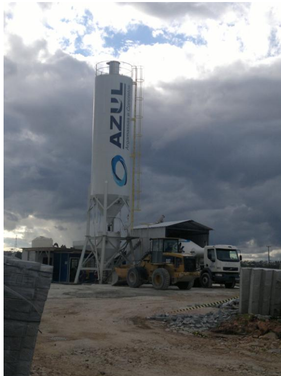
Figura 26 - Central de Concreto utilizada no processo construtivo.
