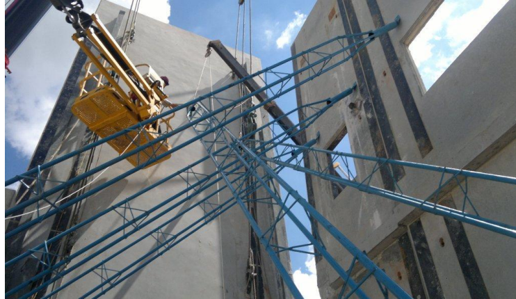
Figura 38 – Execução de escoramento
