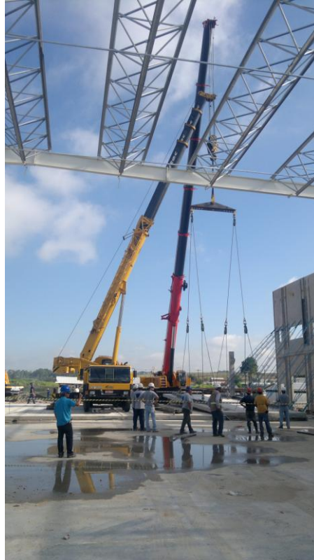
Figura 9 - Utilização de 2 Guindastes para retirada do painel em concreto armado.
