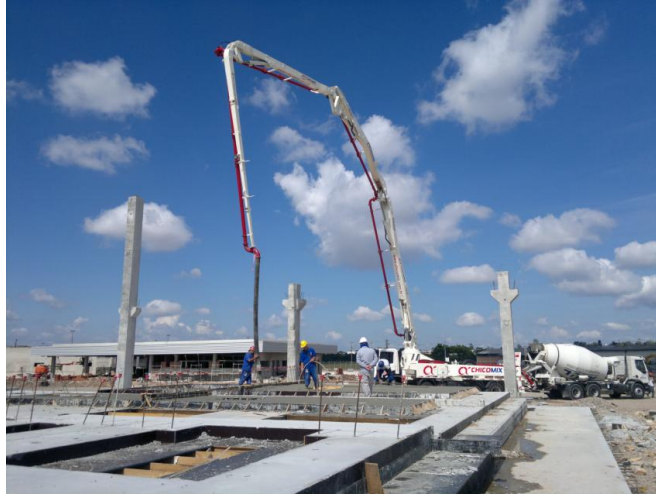
Figura 21 - Foto lançamento de concreto
