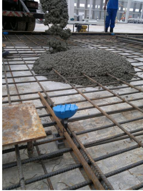
Figura 25 - Lançamento de concreto
