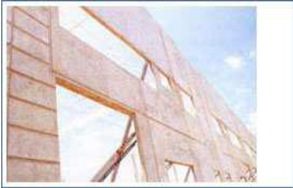
Figura 3 – Escoras são fixadas até que a parede seja solidarizada
