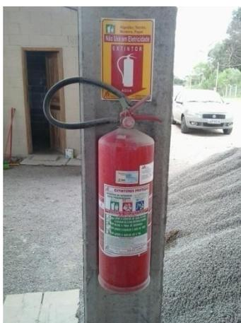
**Figura 27 – Extintor de Água de 10 litros.**
