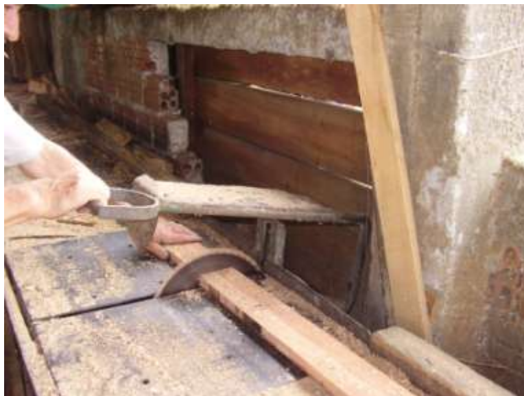
Figura 14- Funcionário operando serra
