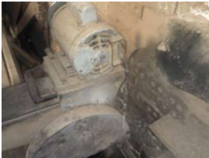
Figura 8- Fiação da serra circular
