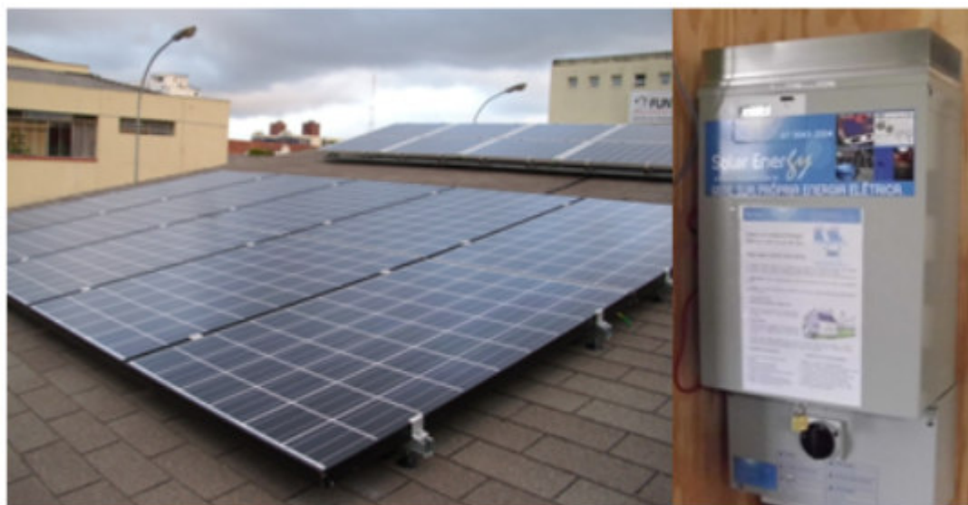
Figura 11 – Painelel Fotovoltalico e inversor do EV da UTFPR Fonte: URBANETZ E CASAGRANDE (2012)
