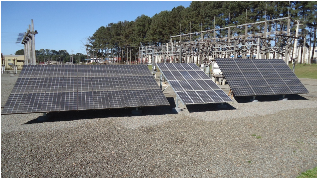
Figura 7 – Detalhe da instalação dos Painéis Fotovoltaicos Fonte: Projeto Piloto COPEL – Sistema Fotovoltaico
