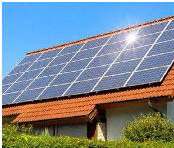
Figura 1: Sistema fotovoltaico conectado à rede aplicado a uma edificação Fonte: CAPITAL TERESINA (2015).
