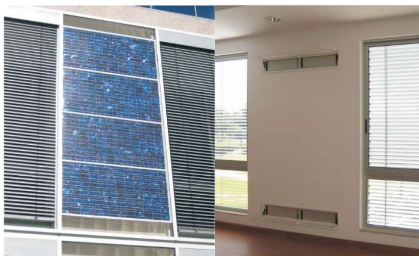
Figura 26 - Detalhe do módulo fotovoltaico integrado no Edifício Solar XXI
