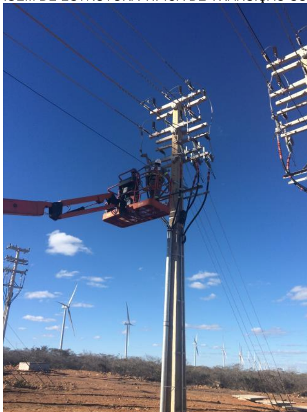
FIGURA 13 – MONTAGEM DE ESTRUTURA TÍPICA DE TRANSIÇÃO SUBTERRÂNEO/AÉREO
