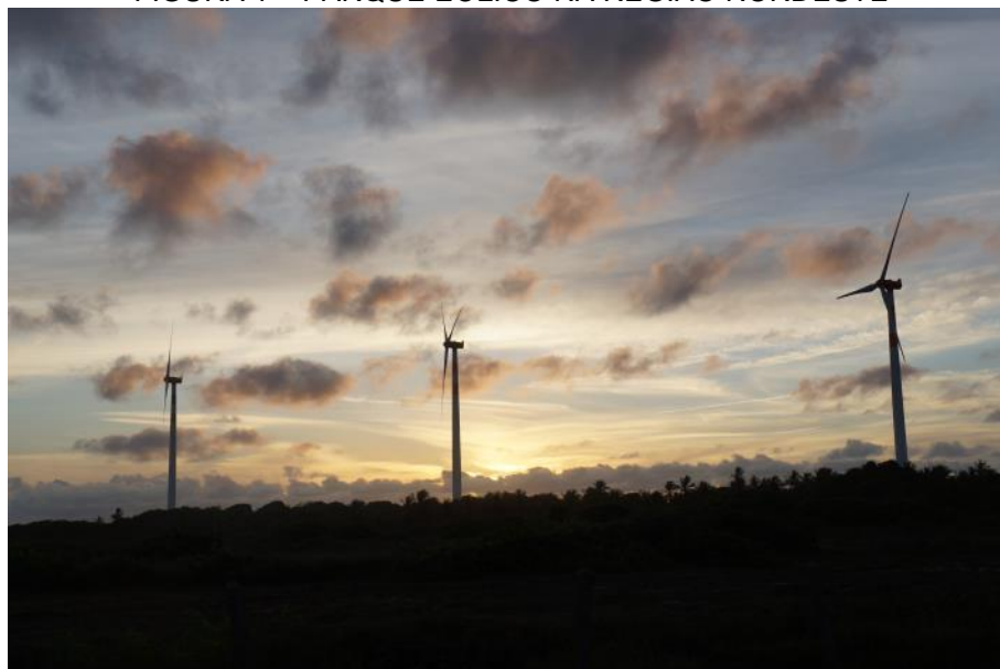
FIGURA 1 – PARQUE EÓLICO NA REGIÃO NORDESTE
