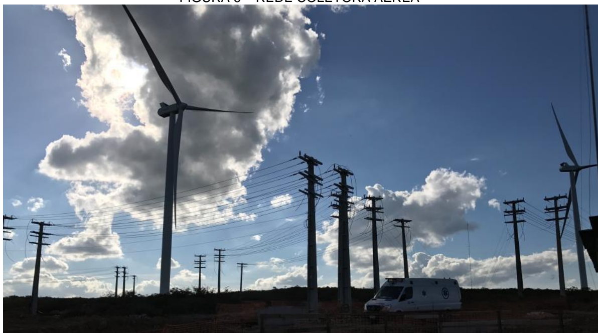
FIGURA 6 – REDE COLETORA AÉREA
