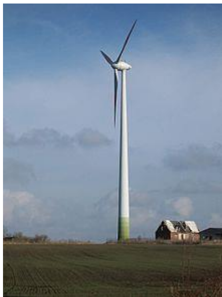
Figura 1 - Aerogerador Enercon E-44
