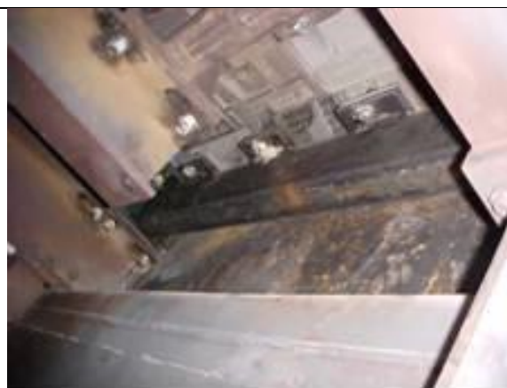
Figura 29 – Viga transversal fixa nova Fonte: Autoria própria.
