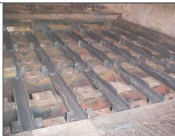
Figura 27 – Vigas centrais novas Fonte: Autoria própria.
