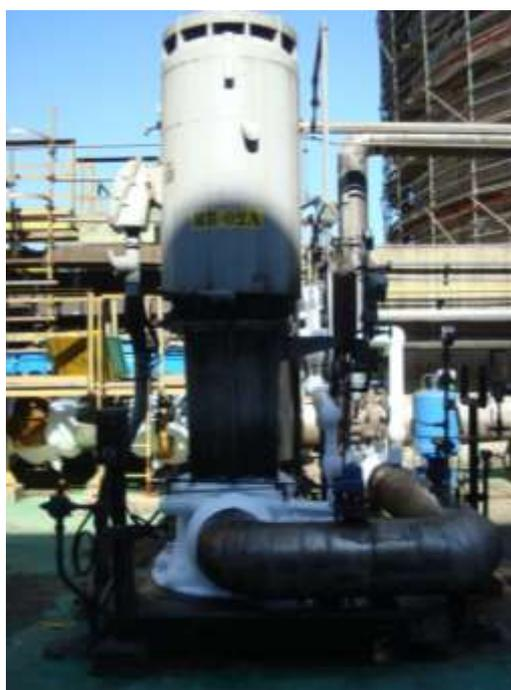
**Figura 21** – Bombas de GLP refrigerado
