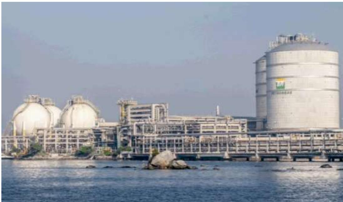
**Figura 13** – Esferas pressurizadas (Esq.) e tanques refrigerados (Dir.)
