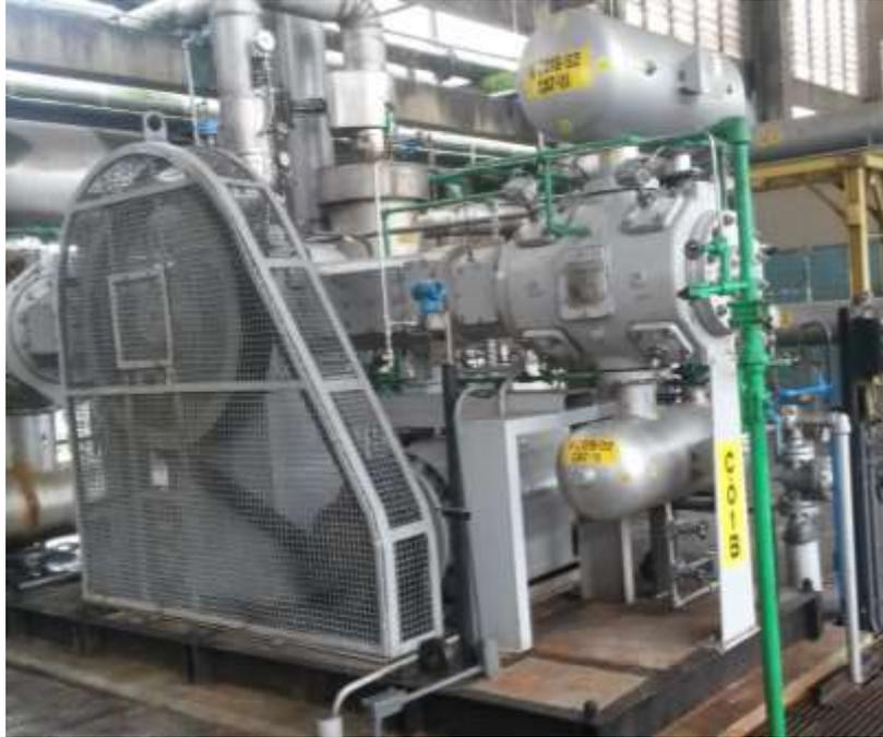
**Figura 18** – Unidade de condensação
