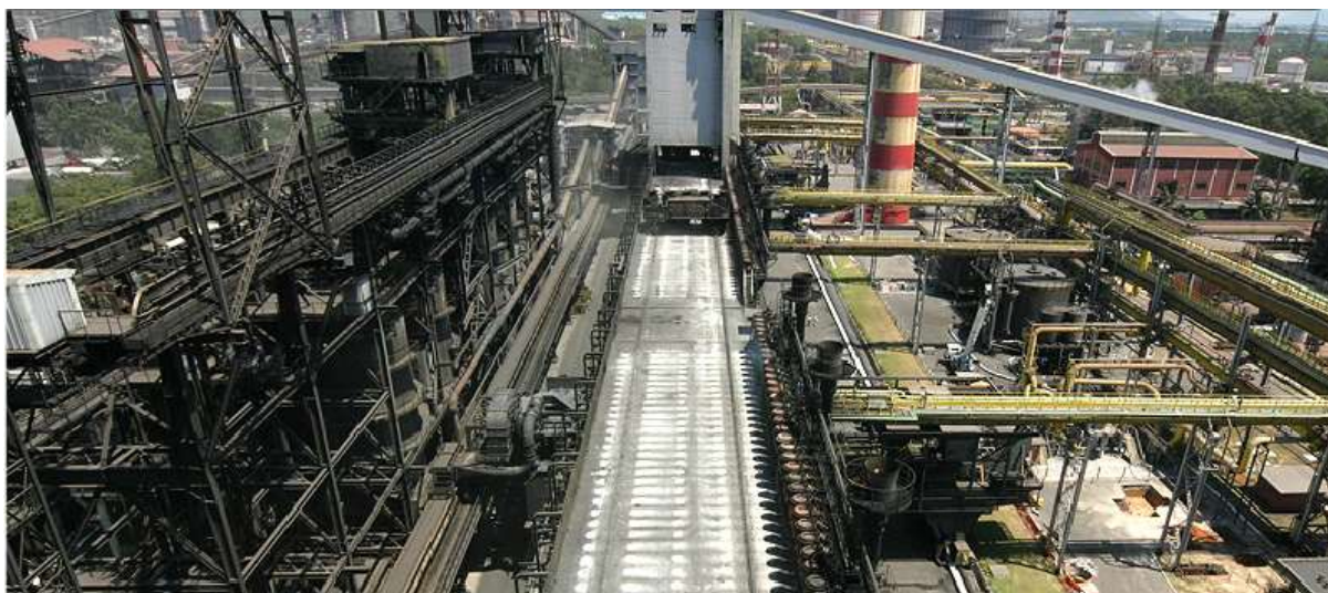
Figura 2.3 – Visão aérea das baterias de coque, CDQ e Tratamento de Gás
