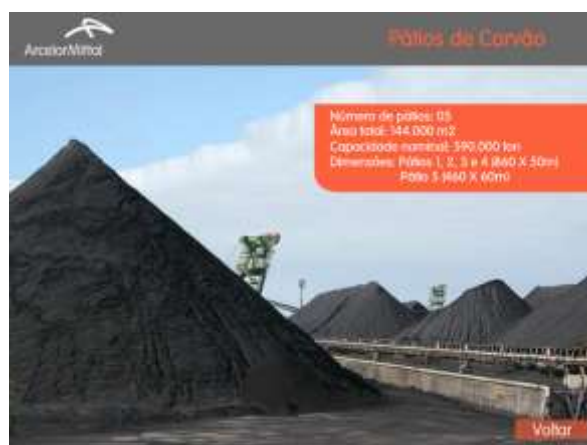
Figura 2.7 – Pátio de Carvão da ArcelorMittal Tubarão
