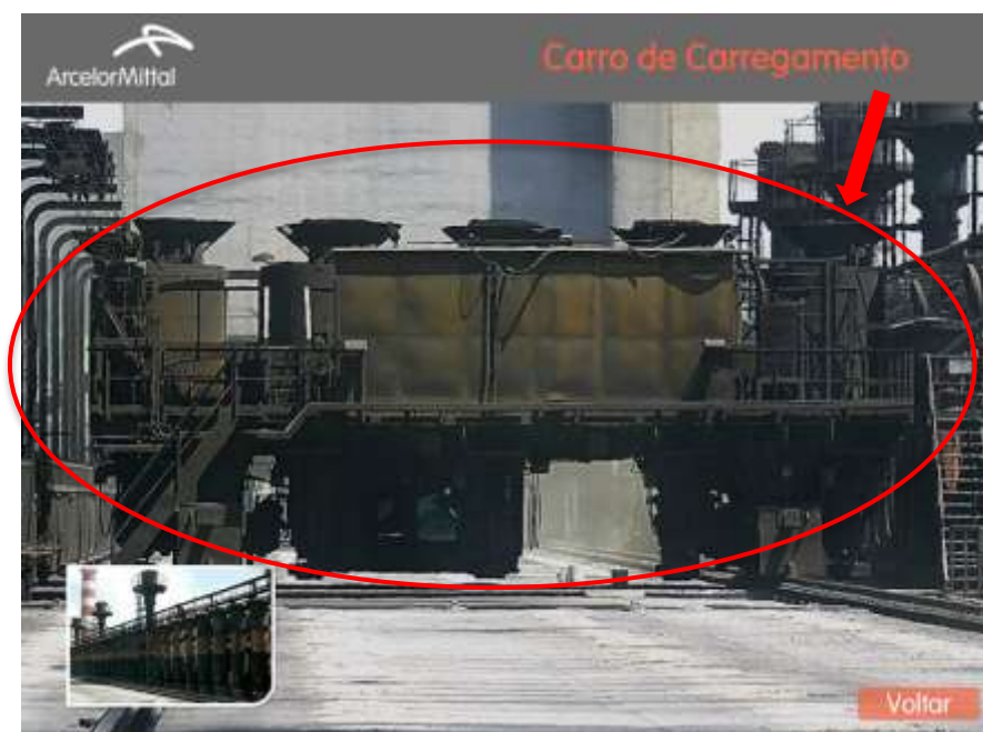
Figura 2.4 – Carro de Carregamento da Arcelormittal Tubarão
