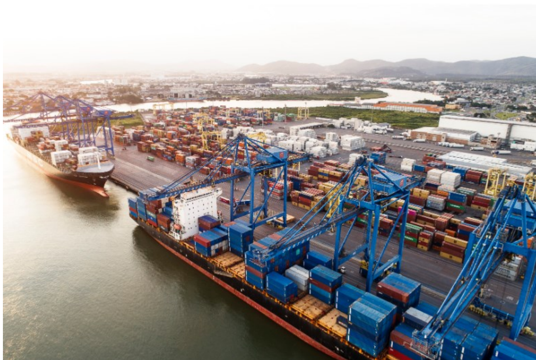
Foto 2.1 – PORTONAVE S/A - Terminal Portuário de Navegantes
