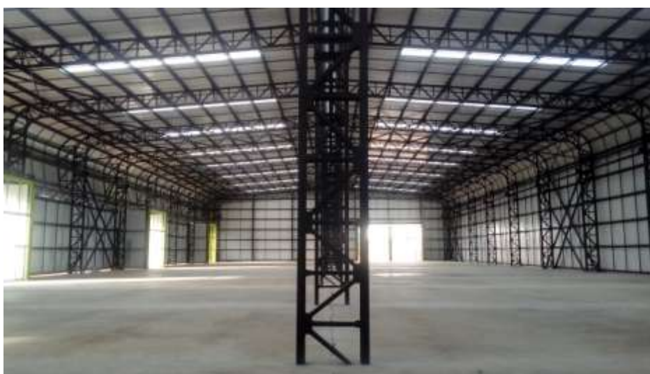
Figura 1 - Barracão industrial. Fonte: O autor, 2017.
