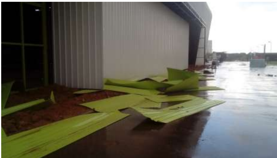
Figura 12 - Acidente com as chapas metálicas que se encontravam no asfalto. Fonte: O autor, 2016.
