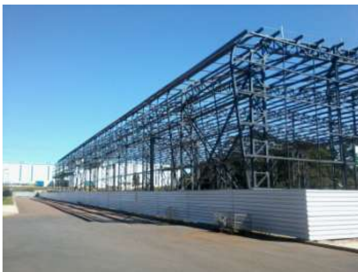
Figura 4 - Estrutura metálica do barracão industrial. Fonte: O autor, 2016.
