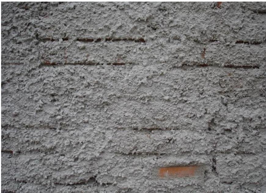
Figura 6 - Parede Chapiscada. Fonte: Blog Cimento Mauá, 2018.
