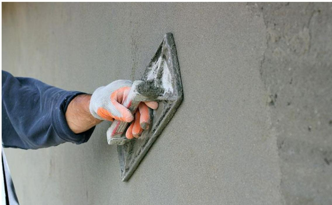
Figura 8 - Aplicação de Reboco em parede. Fonte: Blog Mapa da Obra, 2016.
