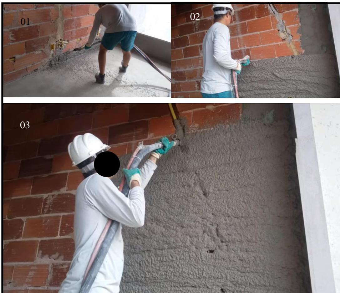
Figura 25- Projeção de Reboco sobre Parede. Fonte: Canal Aguinaldo dos Anjos, 2016. Editado pela autora.
