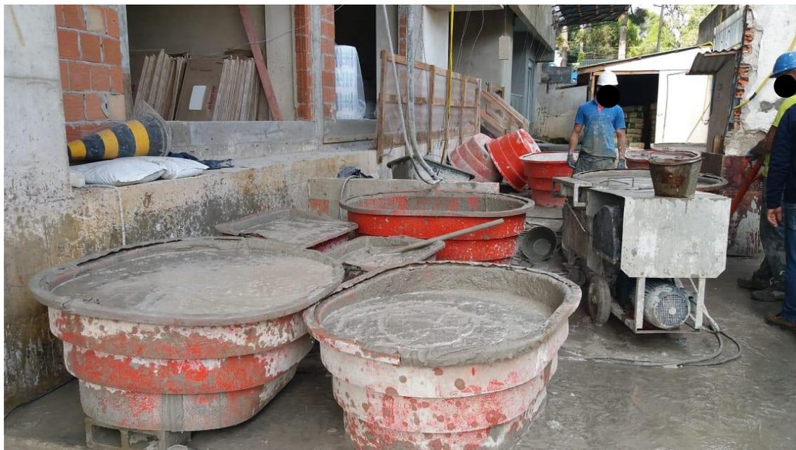
Figura 17 - Armazenamento de argamassa para projeção. Fonte: autoral.
