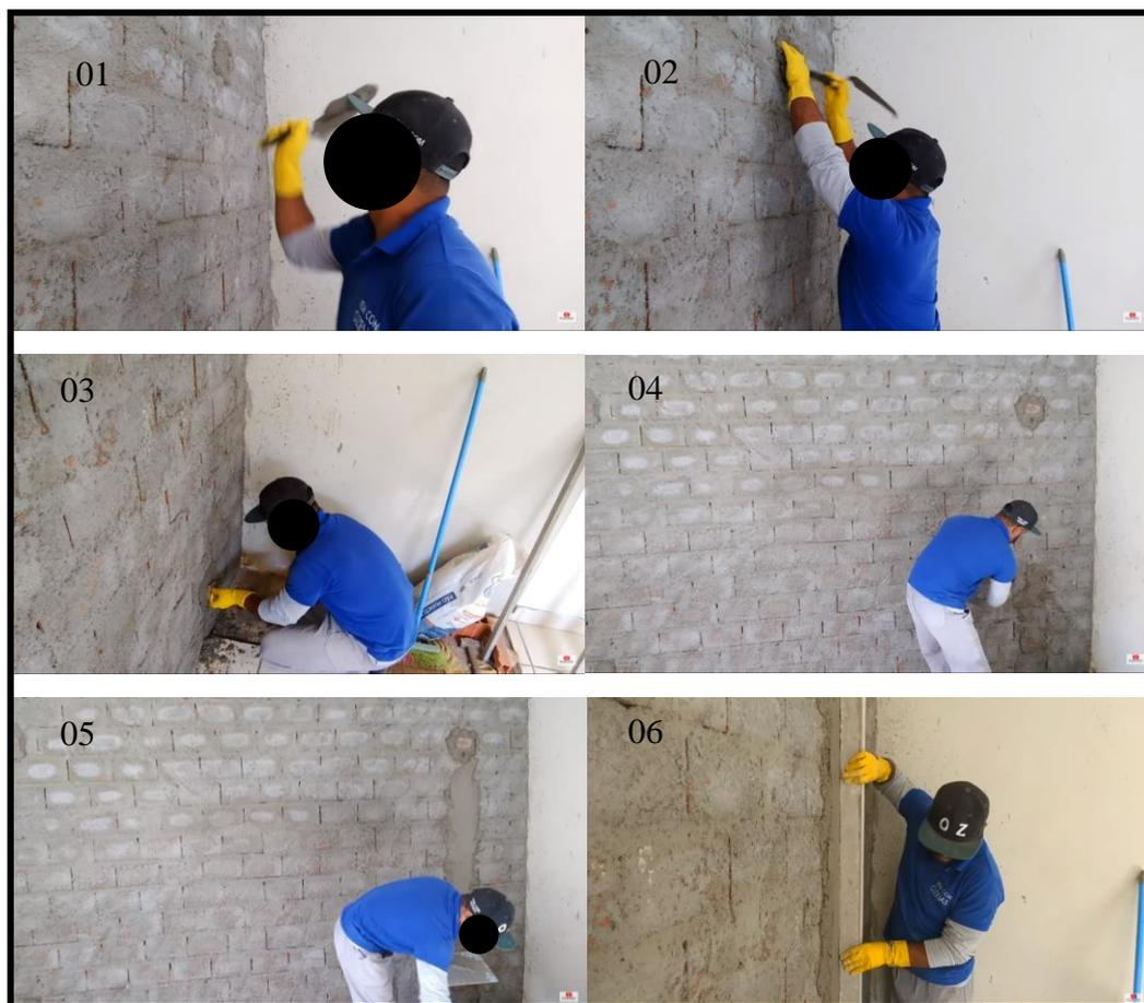
Figura 20 - Posições para execução de mestras durante aplicação de argamassa a manual. Fonte: Vídeo Vem Com Ozéias na Construção, 2018. Editado pela autora.
