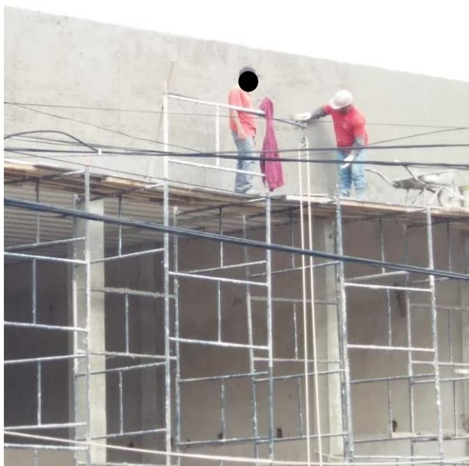
Figura 15 - Aplicação da desempenadeira sobre reboco. Fonte: autoral.
