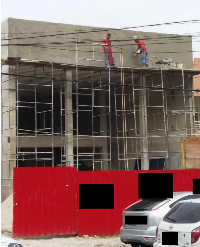
Figura 13 - Aplicação de Reboco Manual sobre Fachada. Fonte: autoral.
