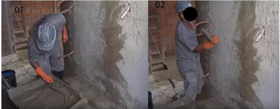
Figura 9 – Execução das mestras para execução de reboco em parede. Fonte: Vídeo “Reboco de Parede, Passo a Passo! [Pedreirão]”, 2015 e editado pela autora.
