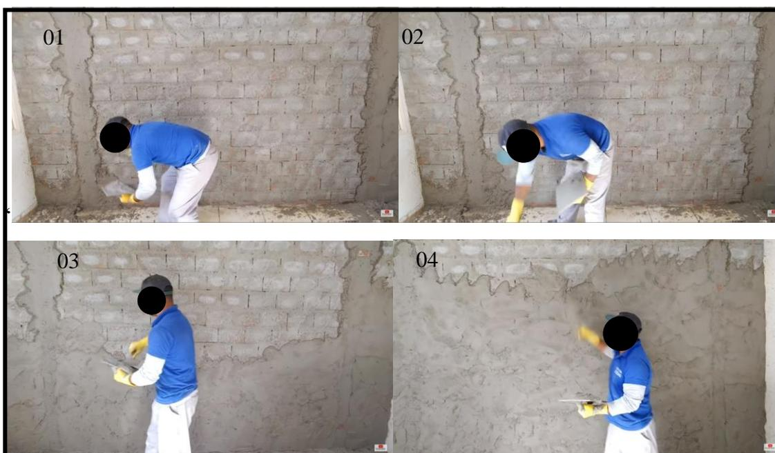
Figura 21 - Posições para aplicação de argamassa manual em parede. Fonte: Vem com Ozéias na Obra, 2018. Editado pela autora.
