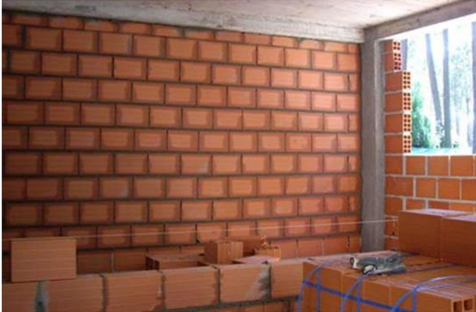
Figura 5 - Parede em alvenaria, com tijolos ligados por argamassa. Fonte: Pedreira.com, 2019.
