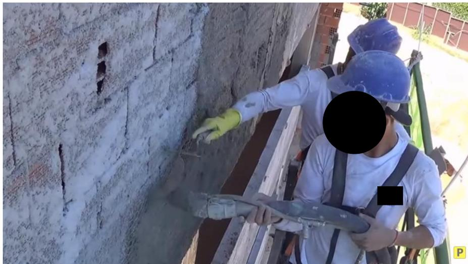
Figura 10 – Execução da projeção de argamassa em parede. Fonte: Vídeo “Reboco Projetado em Fachada, Passo a Passo! [Pedreirão]”, 2015 e editado pela autora.
