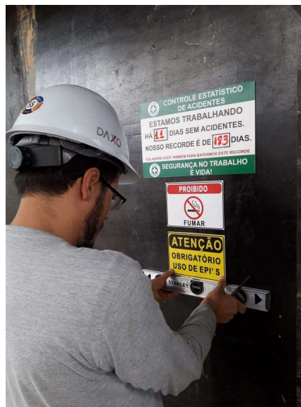
Figura 9 - Placas de identificação em pontos do canteiro. Fonte: A autora.
