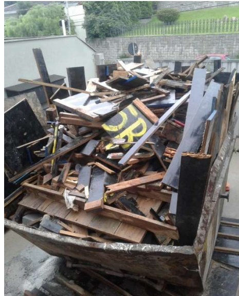
Figura 7 – Caçamba locada para retirada definitiva do canteiro. Fonte: A autora.
