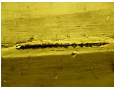
**Figura 7: Fissura gerada no tanque devido a falta de estrutura metálica**
