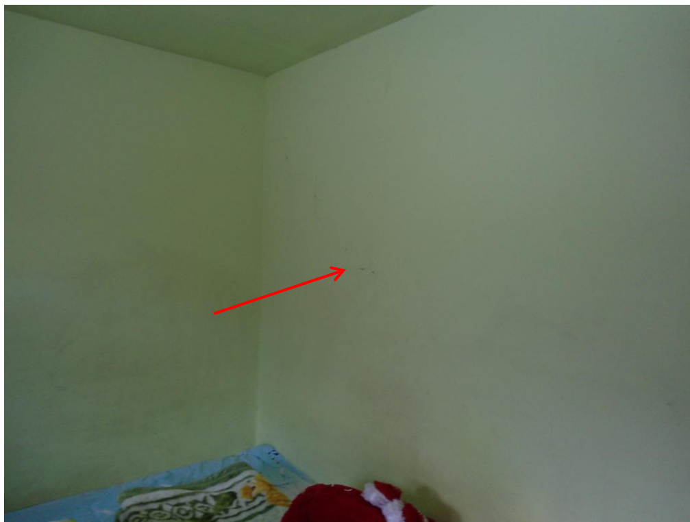
Foto 7 - Dormitório 2 - Fissuras
