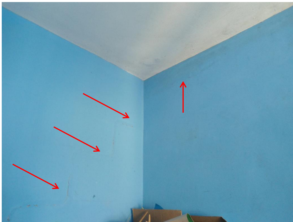
Foto 5 - Dormitório 1 - Fissuras
