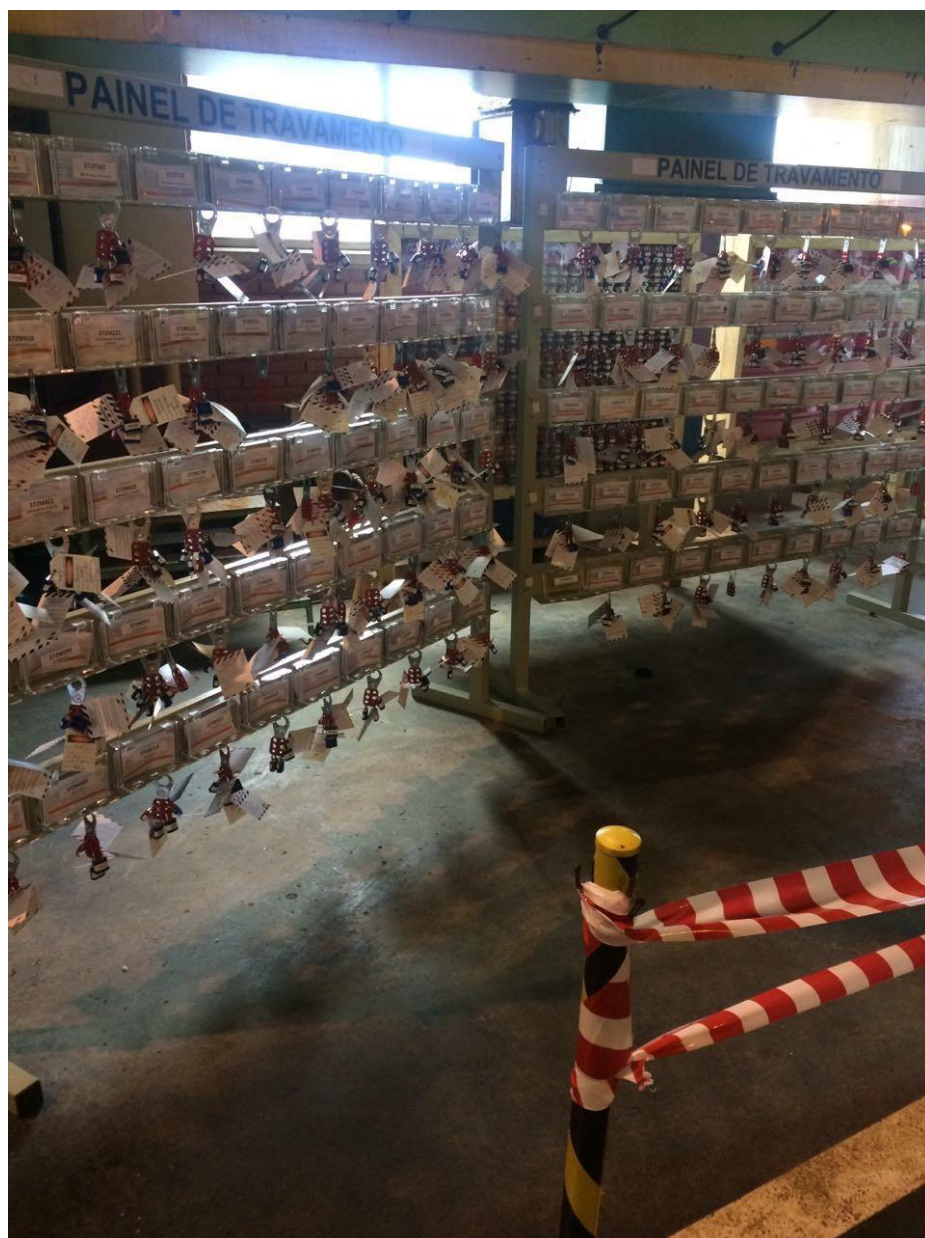
Figura 10 – Estação de multibloqueio para situações onde mais de uma equipe de manutenção atuará sobre um único equipamento bloqueado eletricamente.
