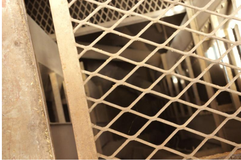
Fotografia 8: Poço do elevador
