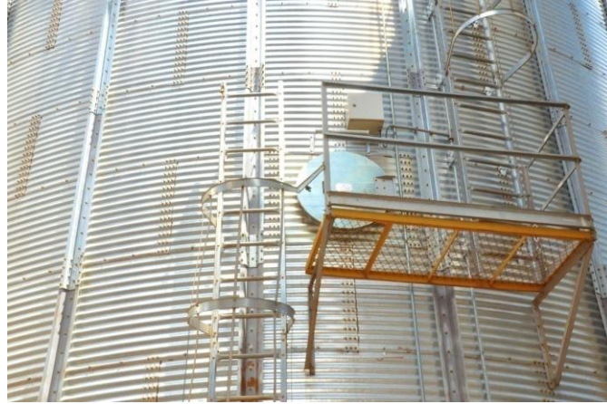
Fotografia 1: Entrada de Silo
