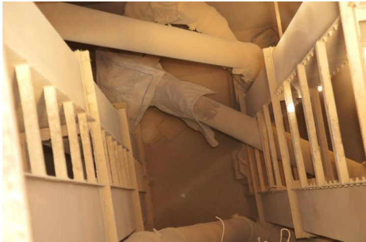
Fotografia 9: Poço do elevador
