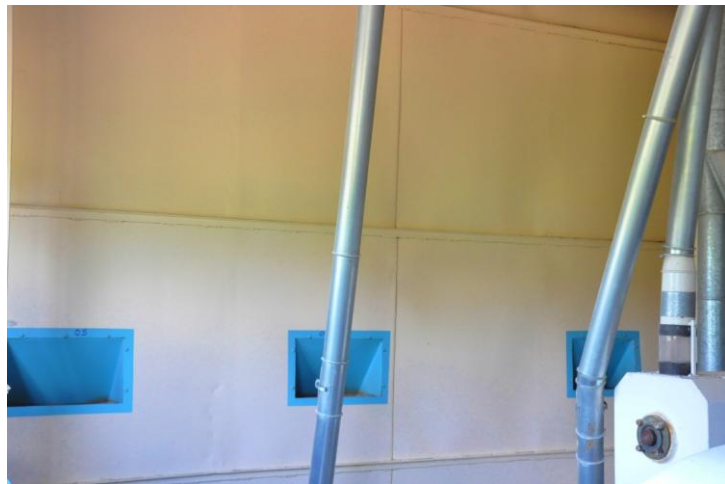
Fotografia 16: Silo de descanso
