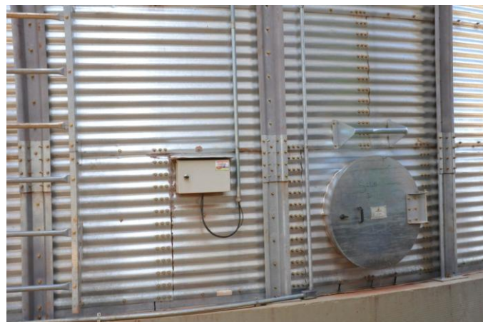
Fotografia 3: Entrada de Silo
