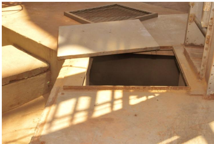
Fotografia 10: Poço do elevador
