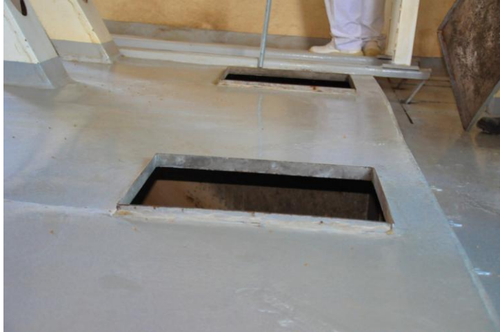
Fotografia 15: Silo de descanso
