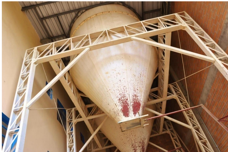
Fotografia 17: Silo de expedição de farelo
