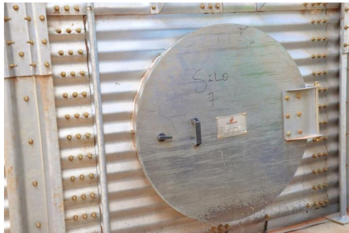
Fotografia 2: Entrada de Silo
