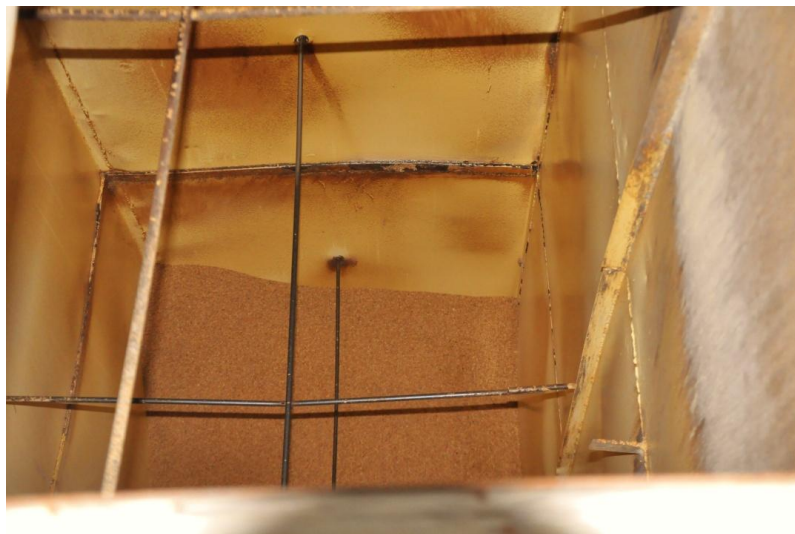
Fotografia 11: Silo de descanso
