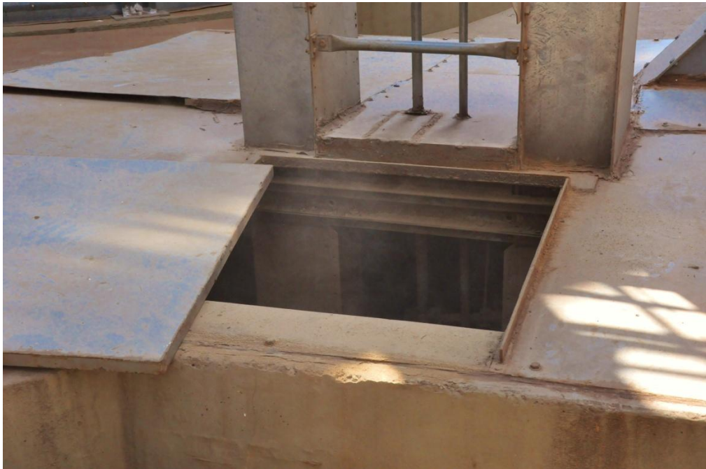
Fotografia 7: Poço do Elevador
