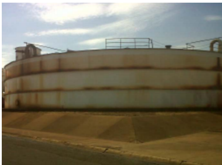
Figura 9: Planta de biodigestão da usina São Martinho.
