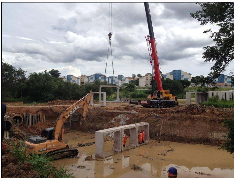
Figura 18 – Execução de obra pública do sistema de drenagem e esgotamento sanitário
