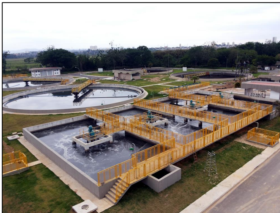
Figura 19 – Estação de Tratamento de Esgotos Lavapés
