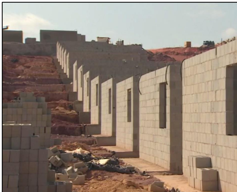
Figura 20 – Construção das unidades habitacionais do Pinheirinho dos Palmares
