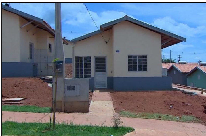
Figura 27 – Imóvel sem instalações sanitárias
