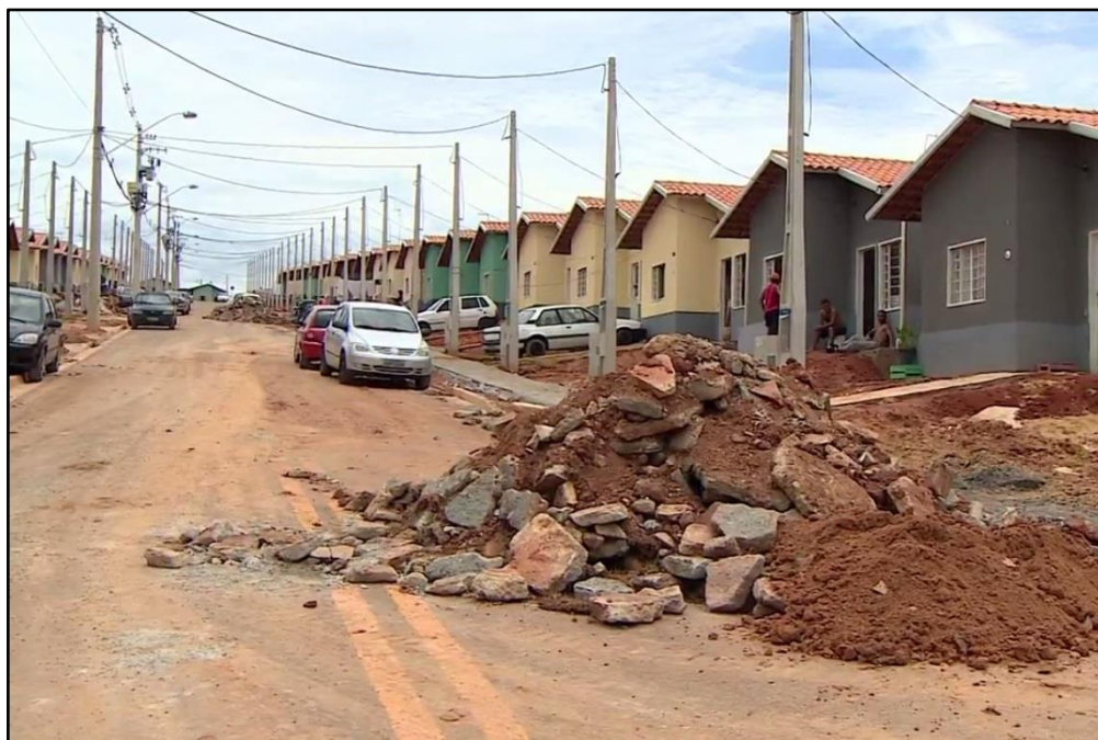
Figura 28 – Execução de serviços de manutenção pós entrega das unidades
