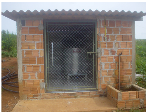
Figura 1 – Tanque de resfriamento instalado no Assentamento 23 de Maio, Bairro Tupi. Fonte: A Autora, 2012.
