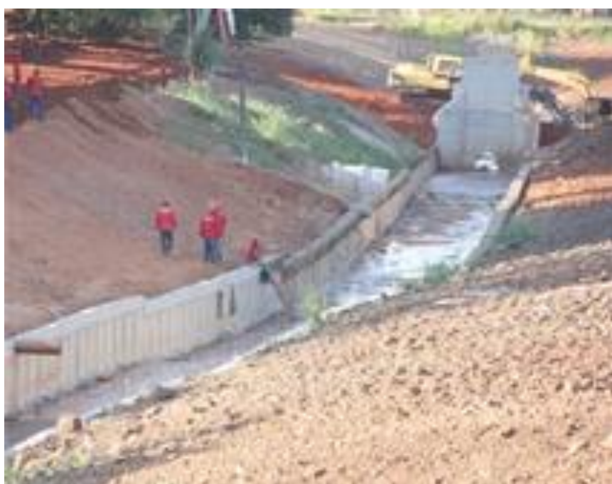
Figura 1 – Imagem da Obra na Avenida Juscelino Kubitschek, em São José do Rio Preto – SP Publicada no Jornal Diário da Região em 2/agosto/2014 Fonte: Marques (2014).
