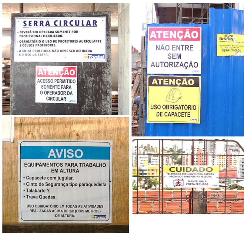
Fotografia 13 - Placas e sinalizações utilizadas no canteiro de obras Fonte: O autor (2014).
