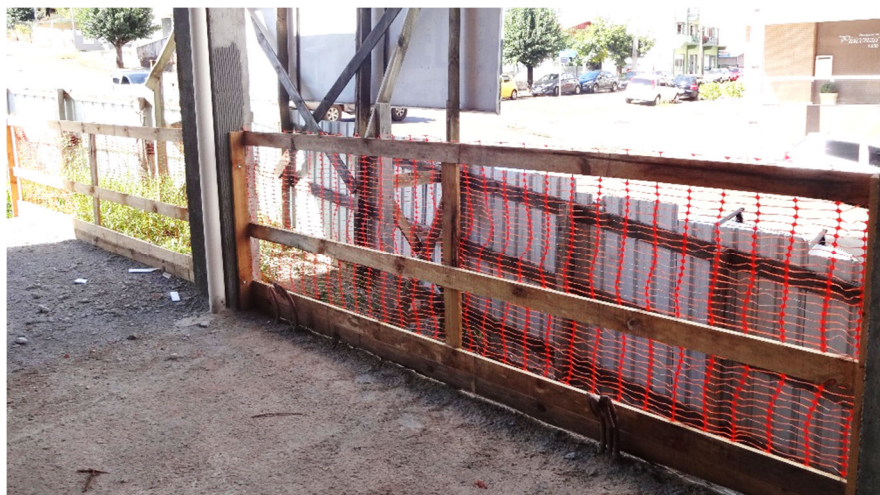
Fotografia 6 - Guarda-corpo instalado no pavimento sobreloja Fonte: O autor (2014).
