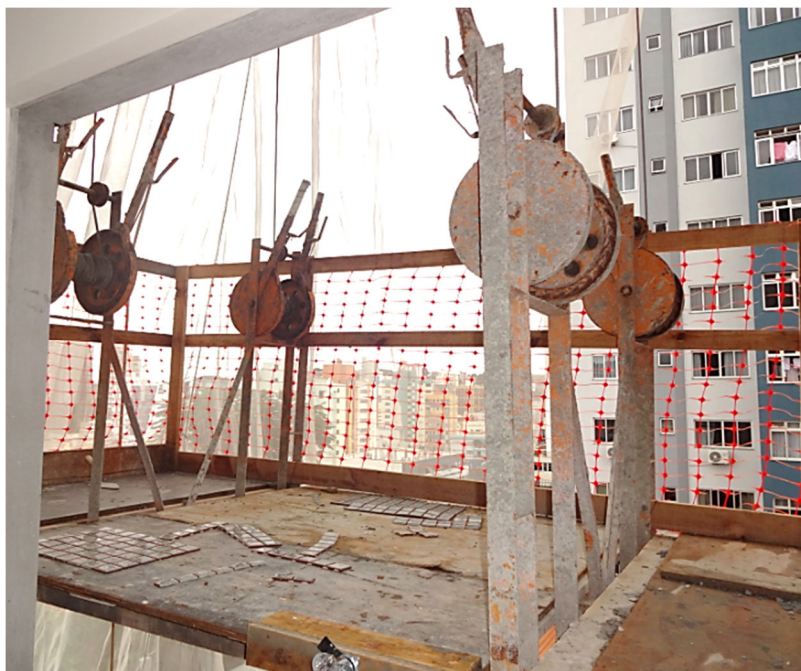
Fotografia 12 - Guarda-corpo instalado em um dos andaimes utilizados no edifício Fonte: O autor (2014).
