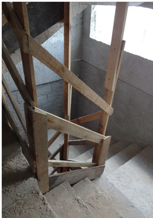
Fotografia 4 - Proteção executada nas escadas de uso coletivo
