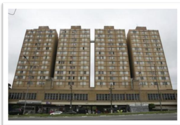
Figura 9: Conjunto Habitacional "Central Parque da Lapa" construído em 1972. Fonte: http://www.comunidadeconstrucao.com.br/banco-obras/1/alvenaria-estrutural .
