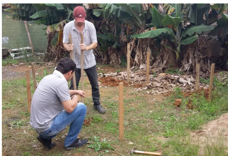
Figura 1 - Construção da composteira.
