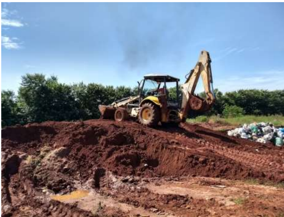
Figura 9 Momento que a retroescavadeira faz a cobertura dos resíduos na trincheira.
