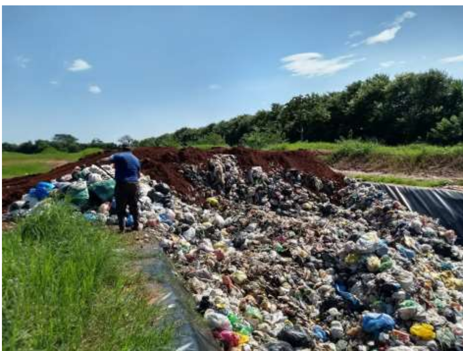
Figura 8 Alocação manual da borda para o interior da vala com auxílio de um garfo de ferro
