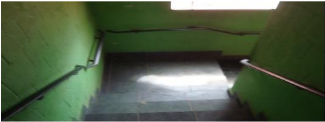
Figura 22 – Cingapura Chácara Bela Vista / vista das escadas internas dos blocos
