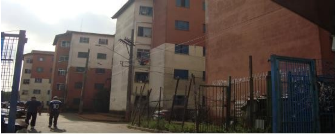
Figura 11 - Cingapura Zaki Narchi / situação atual dos prédios
