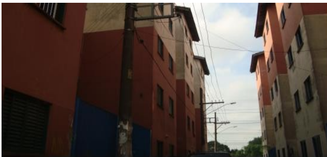
Figura 10 - Cingapura Zaki Narchi / situação atual dos prédios
