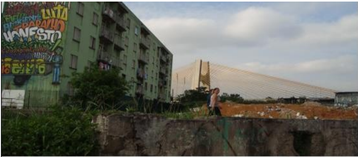
Figura 52 – Favela Estaiadinha / CDHU – Urbanização da antiga Favela do Gato , ao fundo Viaduto Orestes Quêrcia Fonte: Foto tirada pelo autor 28/08/2013
