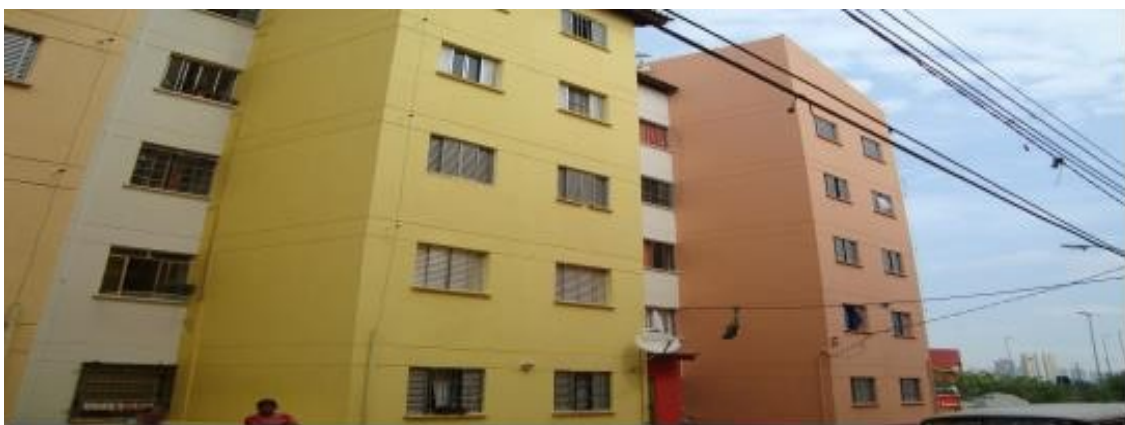
Figura 20 – Cingapura Chácara Bela Vista / situação atual dos prédios
