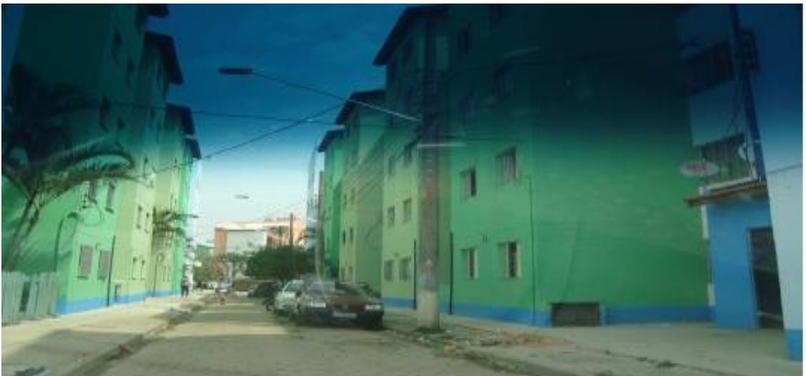
Figura 19 – Cingapura Chácara Bela Vista / situação atual dos prédios
