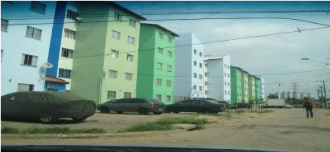
Figura 18 – Vista dos prédios do Cingapura Chácara Bela Vista
