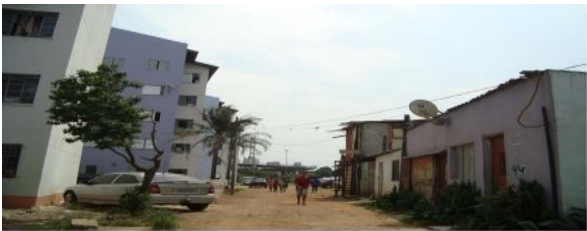
Figura 35 – Cingapura Chácara Bela Vista / a direita construções irregulares em alvenaria e mais adiante em madeira
