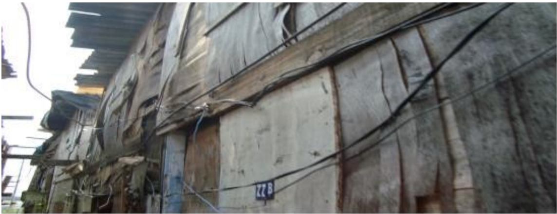
Figura 41 – Favela Esmaga Sapo / fios em que abastassem a energia da comunidade na altura das mãos de uma criança, risco de ferimentos graves
