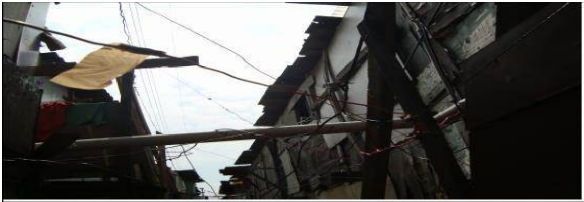
Figura 40 – Favela Esmaga Sapo / emaranhado de fios dentro da comunidade para abastecer os barracos com energia elétrica
