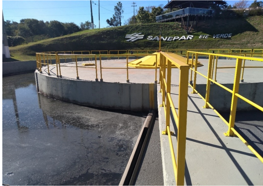
Figura 5. RALF 1, localizado na ETE Rio Verde.
