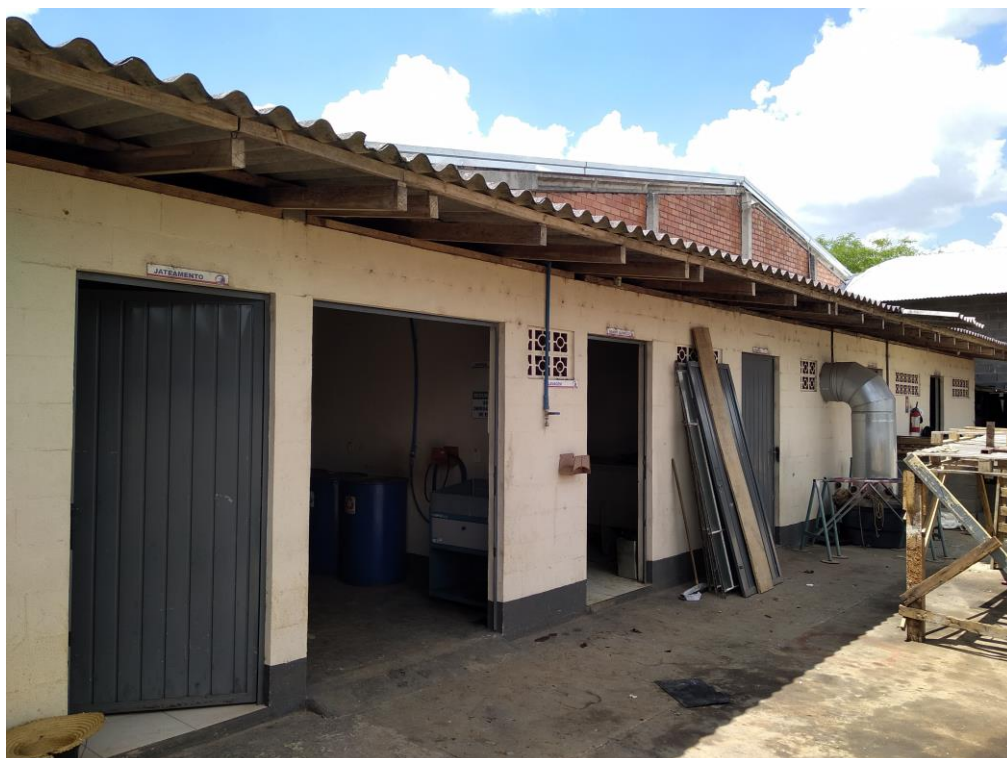
Fotografia 5 – Vista da área externa do hangar
