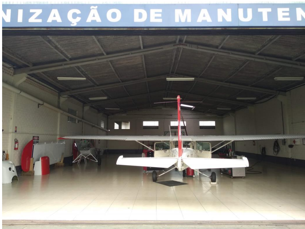
Fotografia 2 – Área destinada à manutenção 1
