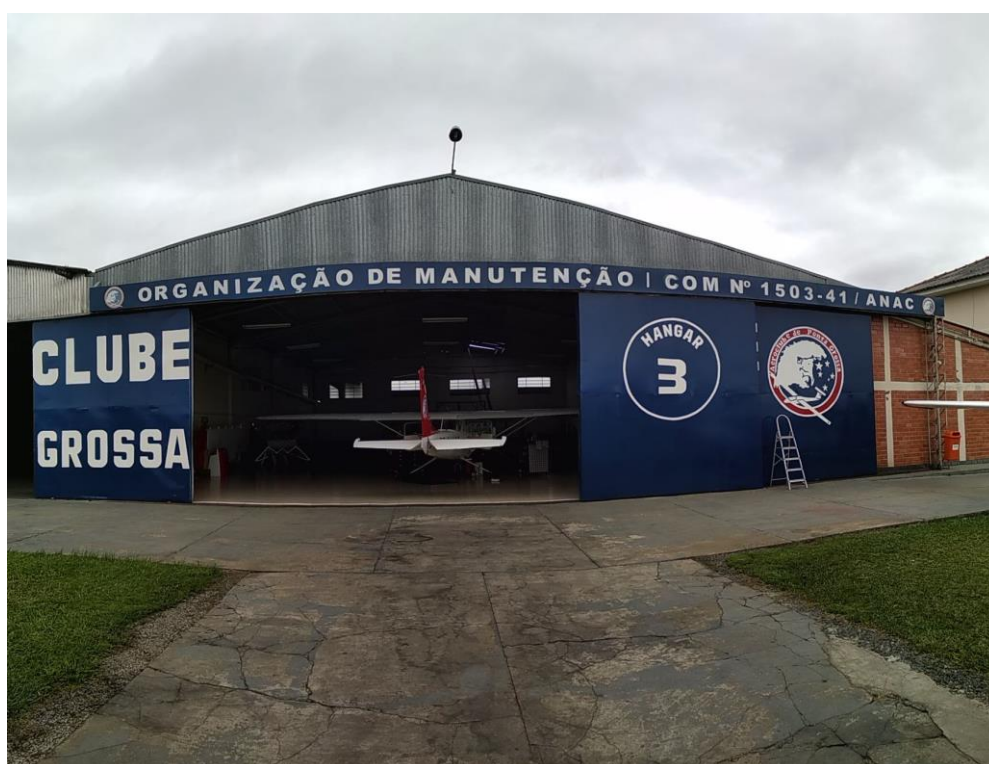
Fotografia 1 – Hangar de manutenção de aeronaves
