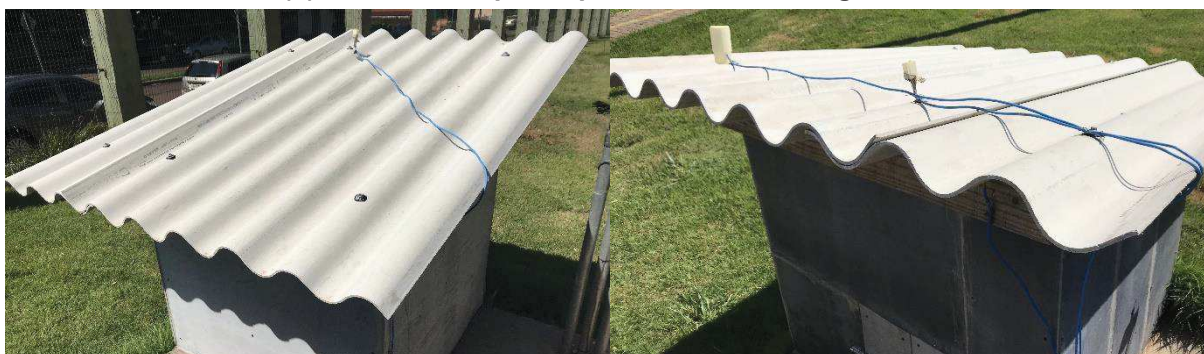
Figura 22 – Instalação dos sensores de chuva e luminosidade: (a) cobertura do protótipo das técnicas brasileiras e (b) cobertura do protótipo da técnica estrangeira
