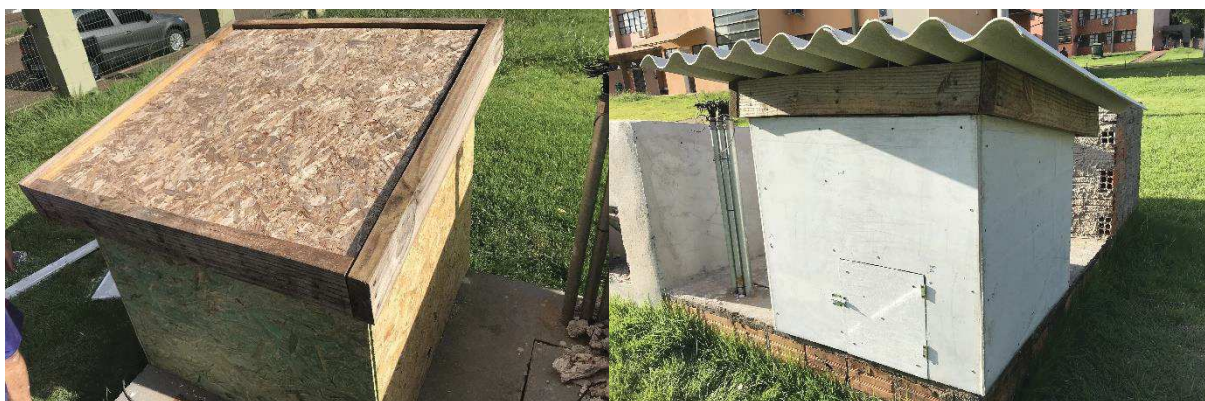
Figura 20 – Revestimento externo do protótipo: (a) contraventamento em chapas de OSB e (b) revestimento em placas cimentícias
