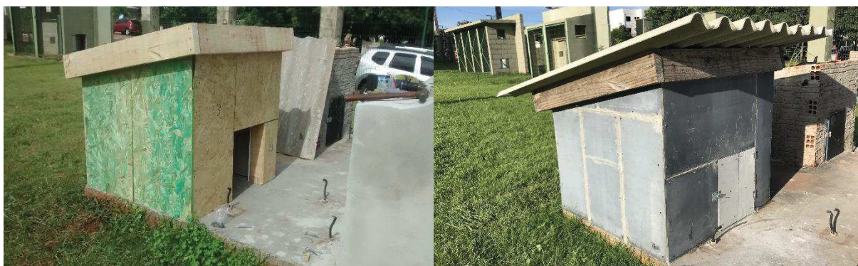
Figura 16 – Revestimento do protótipo: (a) contraventamento com chapas de OSB e (b) revestimento em placa cimentícia e instalação do telhado e da porta
