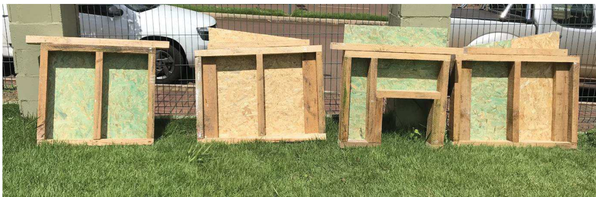
Figura 17 – Painéis de paredes
