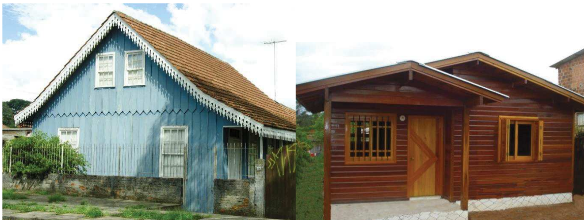
Figura 5 – Residências no sistema viga-pilar: (a) vedação em tábuas e mata-junta e (b) edificação pré-fabricada
