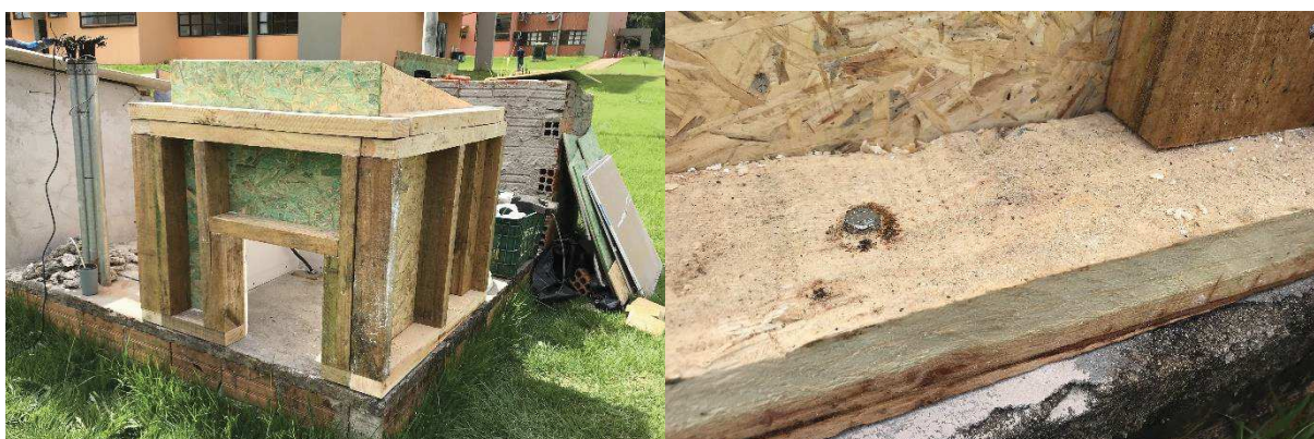
Figura 18 – Montagem da estrutura: (a) encaixe e posicionamento dos painéis de paredes e (b) fixação com parafusos chumbadores
