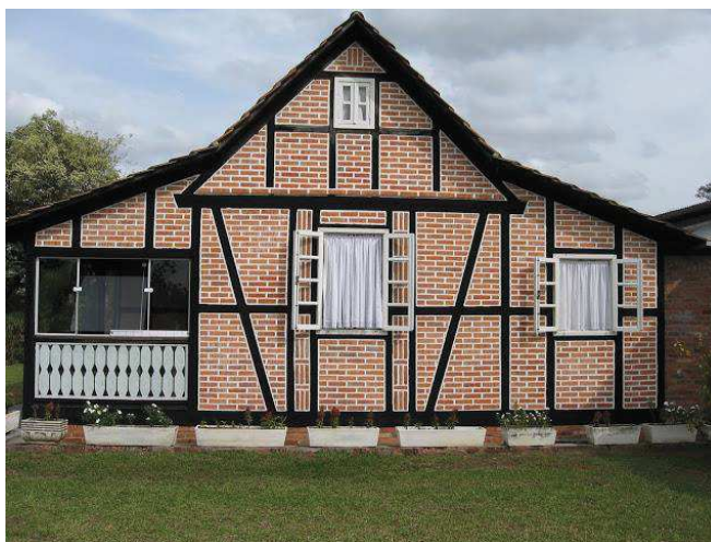
Figura 2 – Técnica construtiva em enxaimel
