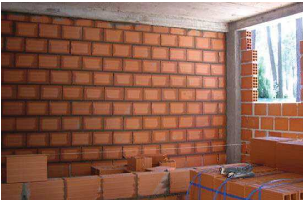
Figura 7– Alvenaria de vedação em blocos cerâmicos
