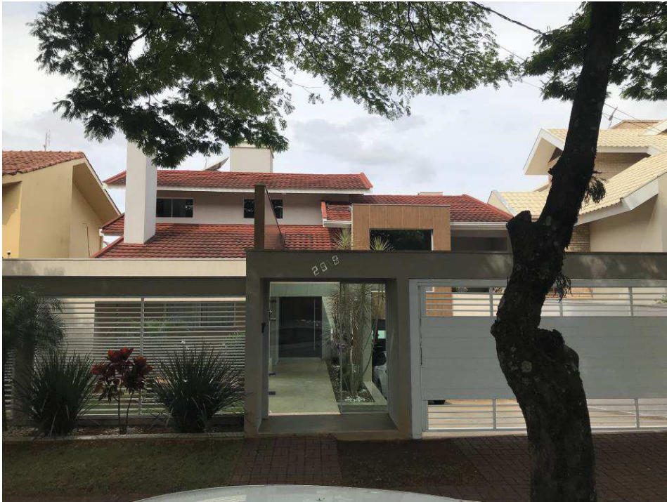
Figura 28 – Residência em alvenaria convencional
