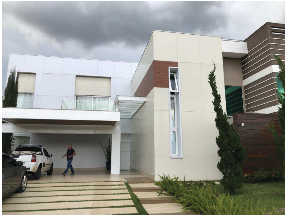
Figura 19 – Residência em Light Steel Framing
