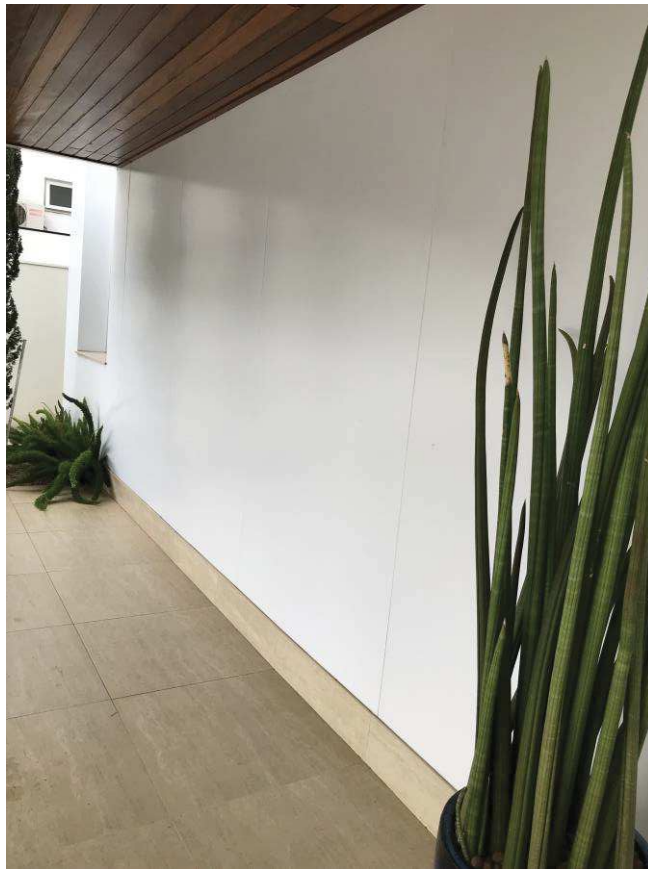
Figura 21 – Garagem externa ao hall
