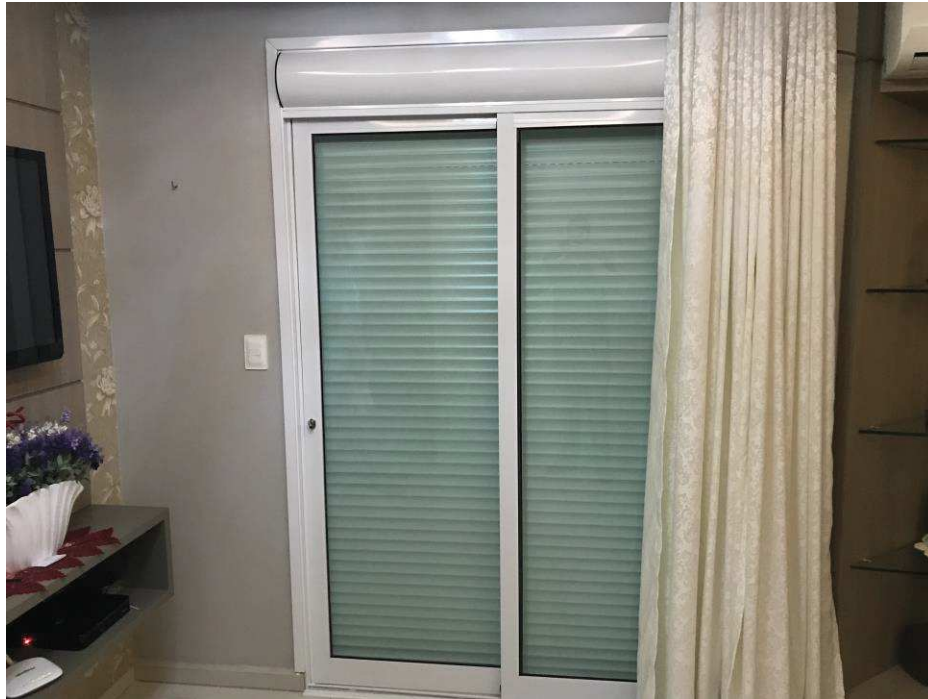
Figura 37 – Parede interna da porta de vidro
