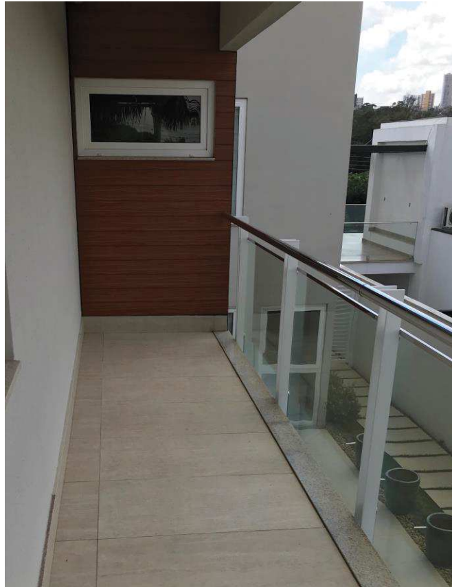
Figura 23 – Corredor externo ao quarto
