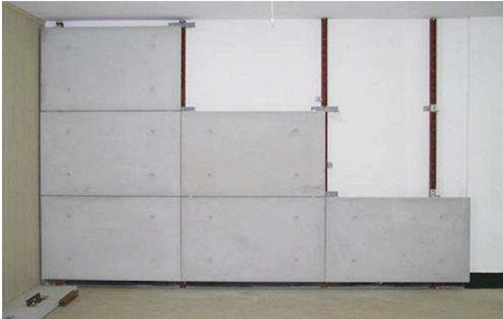
Figura 13 – Fechamento em placas cimentícias
