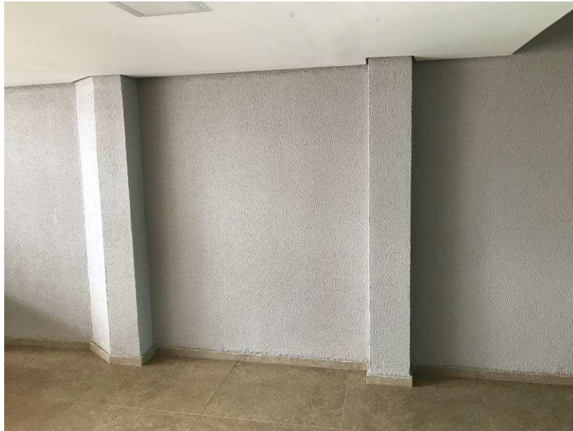
Figura 32 – Parede da garagem
