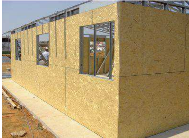
Figura 14 – Fechamento em placas OSB
