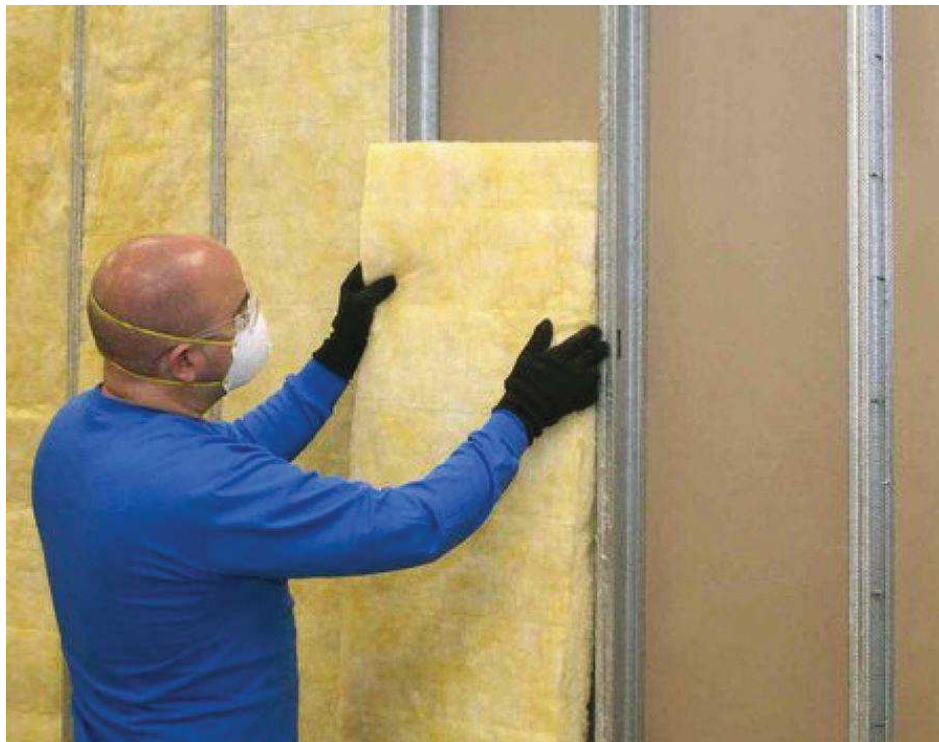
Figura 15 – Preenchimento do painel em LSF com lã mineral
