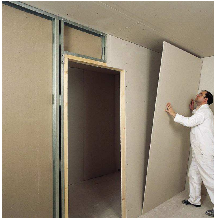
Figura 12– Fechamento em placas de gesso acartonado
