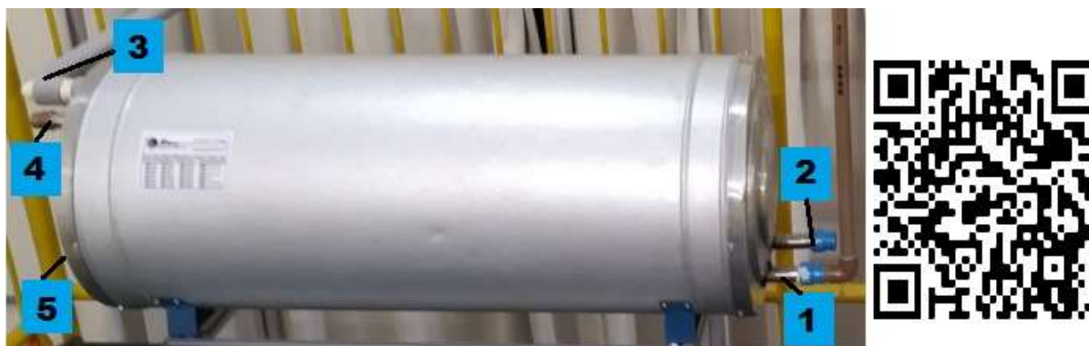
Figura 30 – Canais de acesso do reservatório térmico.
