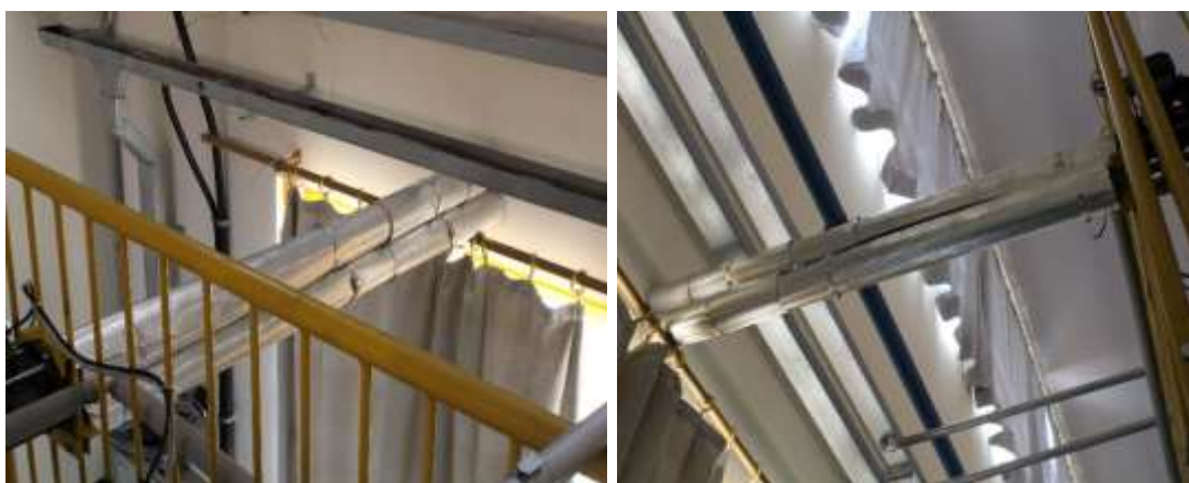
Figura 36 – Resultado da instalação dos isolantes lã de rocha na região interna.
