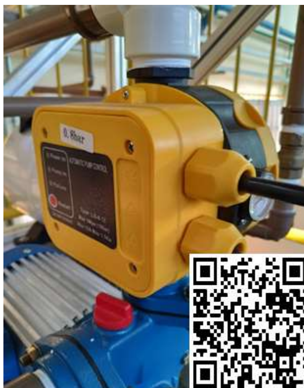
Figura 26 - Pressostato.
