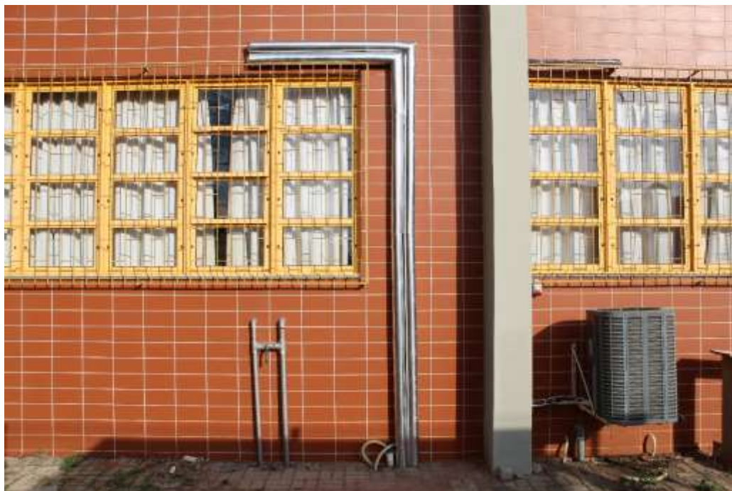
Figura 43 – Resultado final da instalação do isolamento externo.
