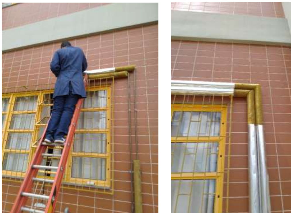
Figura 42 – Instalação dos isotubos.
