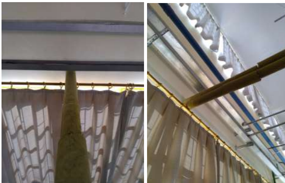
Figura 35 – Isotubos posicionados na tubulação.
