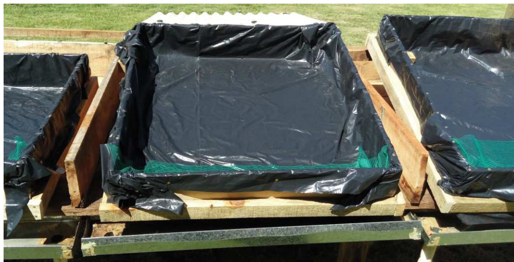
Figura 16 - Fixação dos módulos inclinados.
