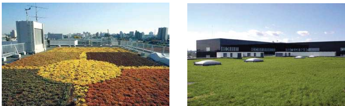
Figura 4 - Telhados verdes extensivos.
