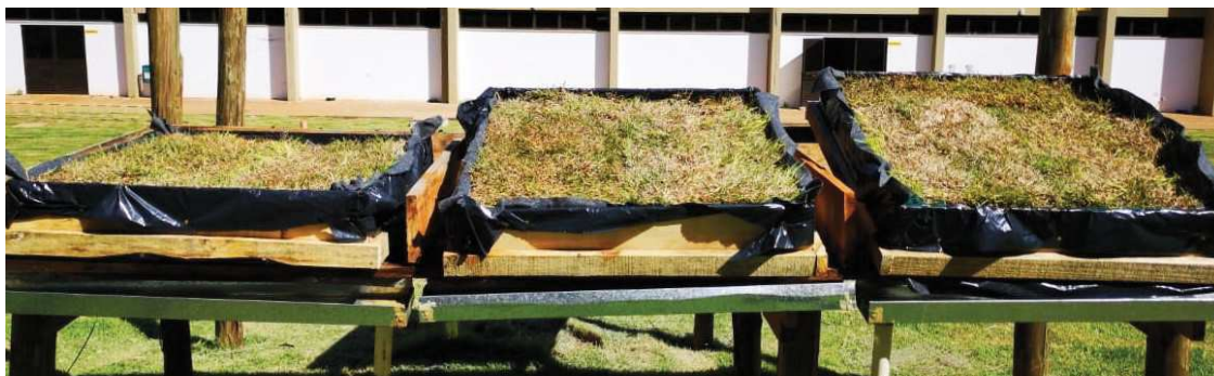
Figura 21 - Módulos de telhado verde ao fim da montagem.
