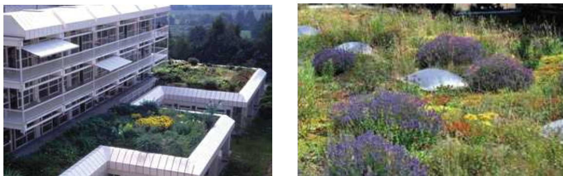
Figura 5 - Telhados verdes semiextensivos.
