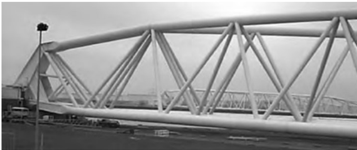
Figura 6 – Exemplo de estrutura de treliça.
