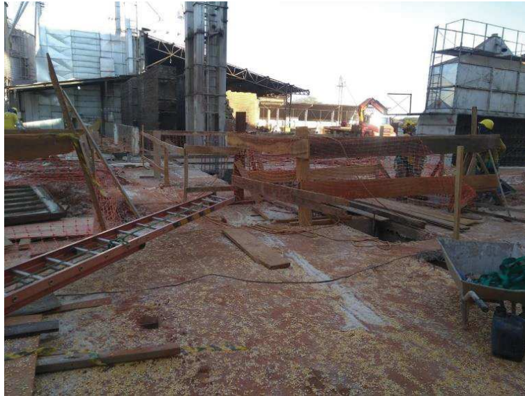
Figura 14. Isolamento de valas e fossos, sinalização de risco com fita zebra e construção de pontes e guarda-corpos
