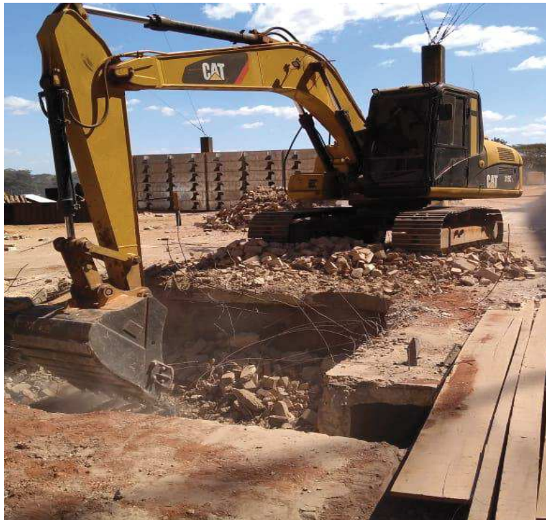
Figura 10. Demolição mecanizada da 1ª laje encontrada no subsolo
