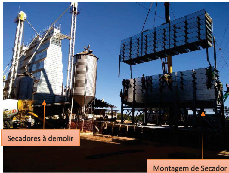
Figura 15. A direita, montagem do primeiro secador novo. A esquerda, secadores a serem demolidos
