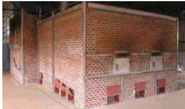
Figura 5. Fornalha em alvenaria com carregamento manual.
