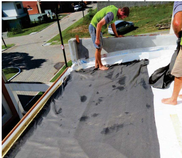
Figura 13: Execução da impermeabilização
