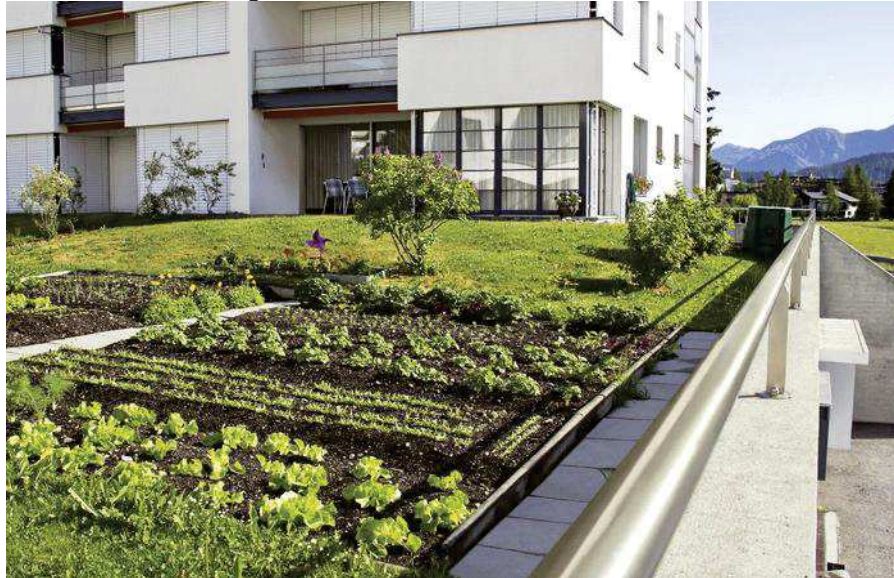
Figura 9: Telhado verde semi-extensivo
