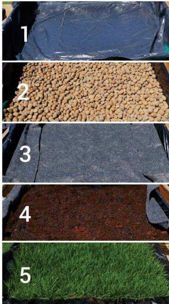
Figura 16: Etapas da construção do telhado verde
