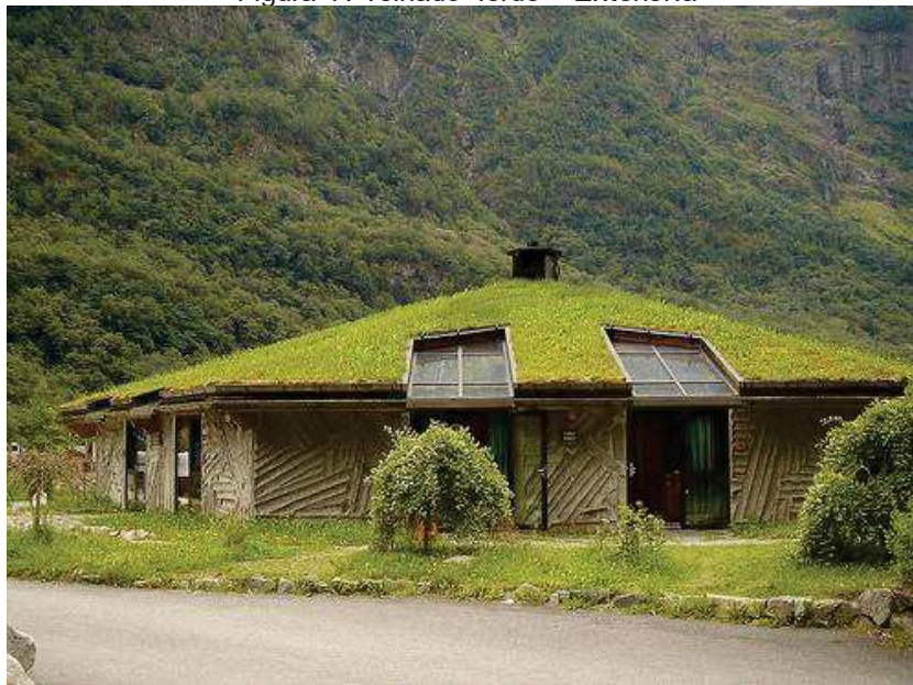
Figura 7: Telhado verde - Extensiva
